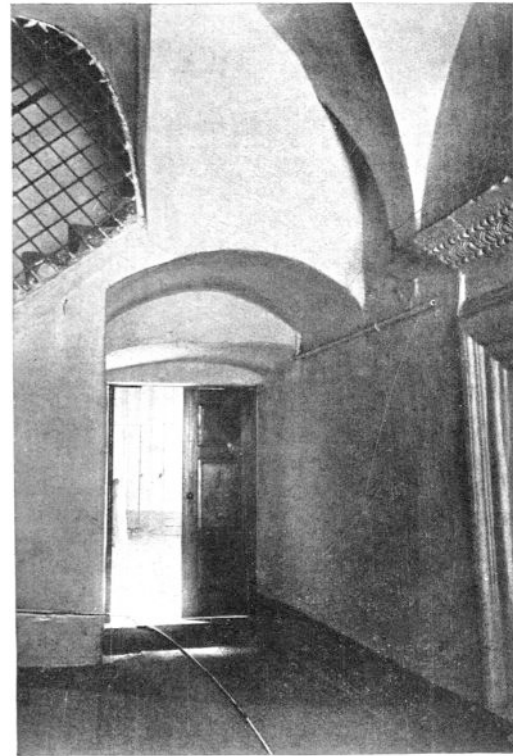
Fig. 15. Sień i część schodów zakratowanych domu na pl. Maryackim l. 3.
