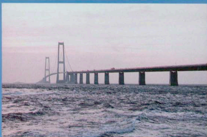
Most przez Wielki Belt – widok ogólny na część wschodnią
