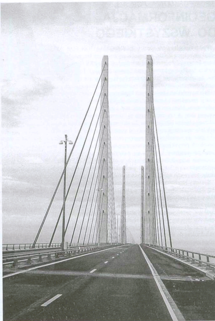
Przeprawa przez cieśninę Oresund (widok na pylony mostu podwieszonoego)
