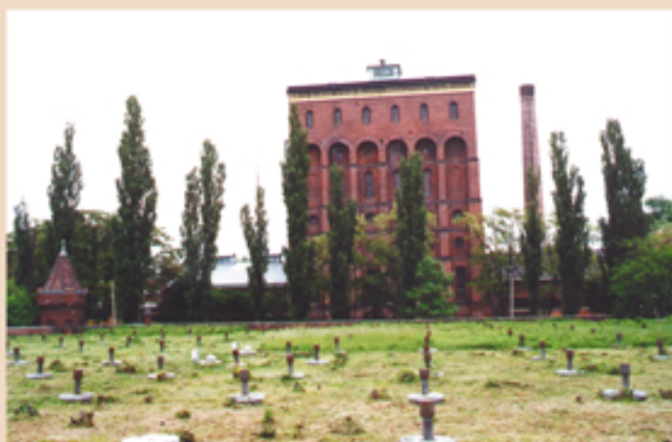
Zbiornik wody czystej
