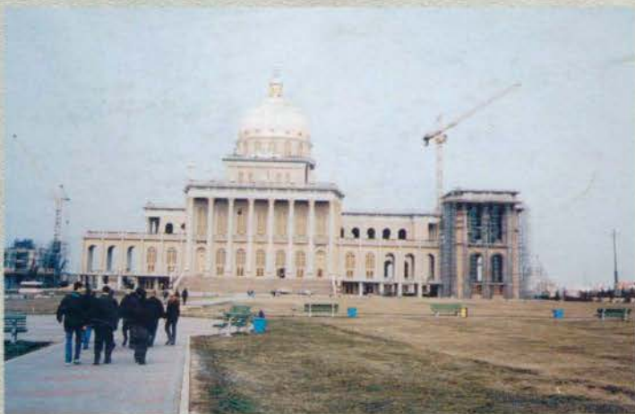
Olbrzymi plac budowy bazyliki daje się jeszcze objąć wzrokiem.
