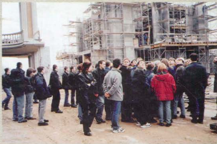
Przy rusztowaniach dzwonnicy
