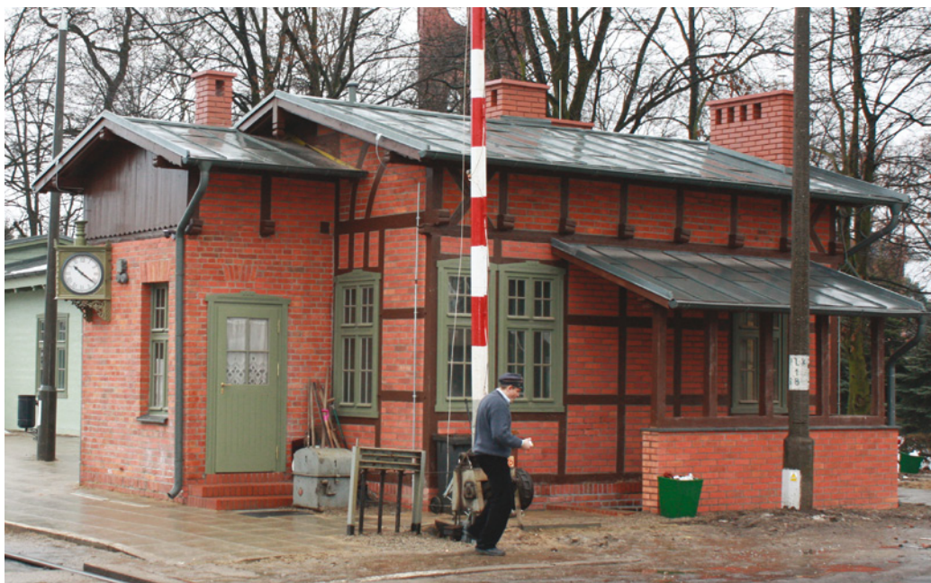
Il. 1. Wyremontowany dworzec w Puszczykówku (fot. E. Grzegorzcyk)
