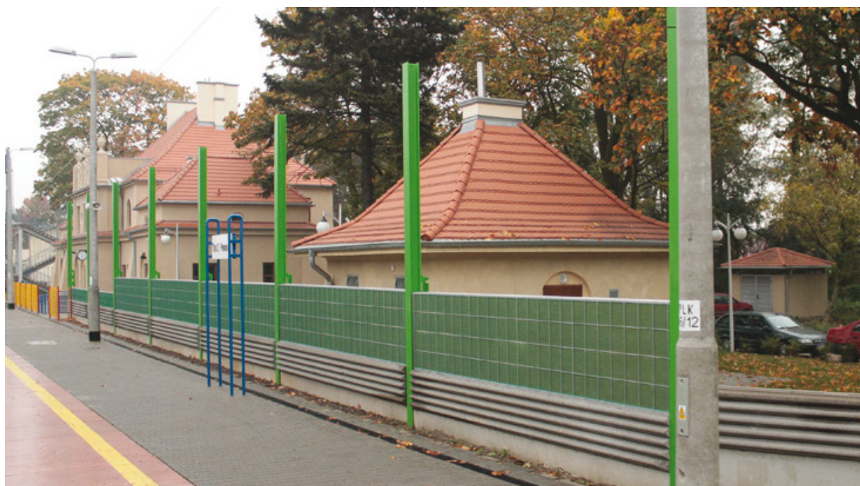
Il. 6. Chaos kolorystyczny peronu i oddzielenie wyremontowanego, zabytkowego dworca od linii kolejowej ekranem dźwiękochłonnym (fot. M. Jerczyński)
