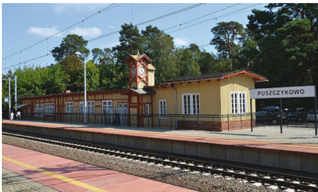
Il. 2. Zmodernizowana stacja w Puszczykówku (fot. E. Grzegorzczak)
