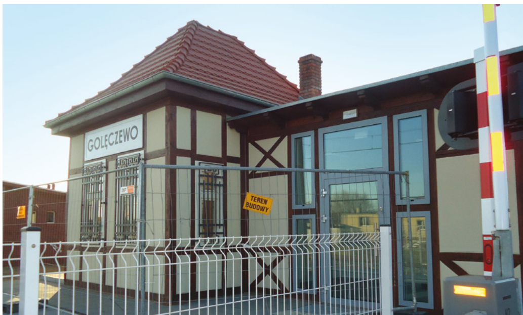
Il. 3. Wyremontowany budynek dworcowy stacji w Golęciewie (fot. E. Grzegorzcyk)
