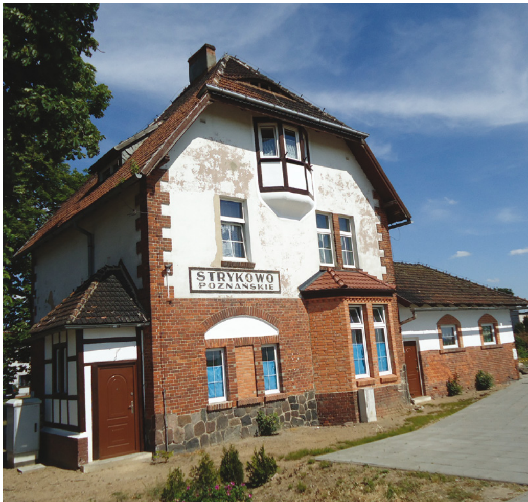
Il. 8. Zmodernizowany budynek dworcowy stacji w Strykowie Poznańskim (fot. E. Grzegorzcyk)
