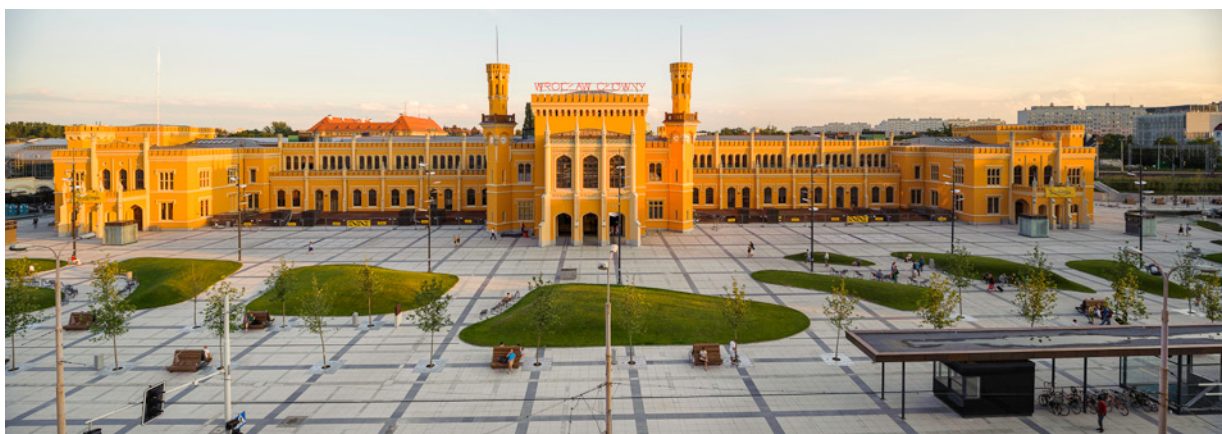
Il. 12. Przebudowany plac przed dworcem i odrestaurowana fasada Dworca Głównego PKP. Projekt: Grupa 5 Architekci, gł. proj.: arch. Rafał Zelent, inwestor: PKP S.A., generalny wykonawca: Budimex S.A. Warszawa, wykonawca prac konserwatorskich: Castellum Sp. z o.o. Stan z 2012 r. (fot. J. Sokołowski)
