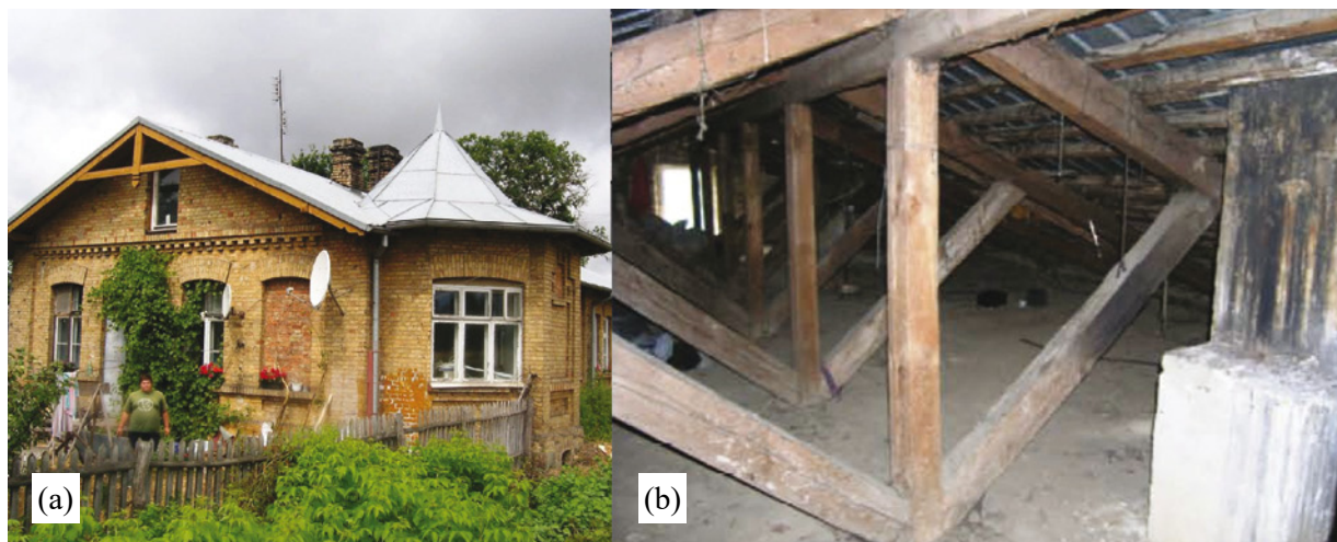
Il. 7. Lewki na szlaku Czeremcha–Bielsk Podlaski: (a) budynek tzw. dworca ze starannie opracowaną ceglana elewacją, wznoszony jako nastawnia z charakterystycznym aneksem umożliwiającym obserwację torowiska, ale oddany do użytku ok. 1914 r. jako mieszkanie kolejarskie, (b) fragment więźby dachowej. Stan w 2005 r. (fot. A. Oleksicki)
