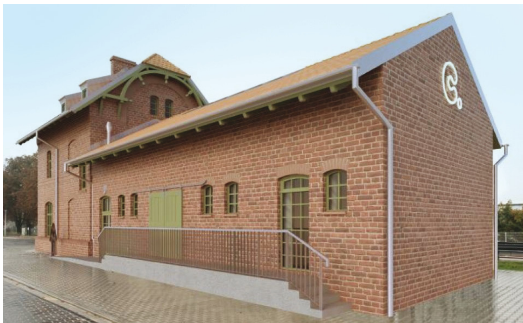
Il. 5. Wyremontowany budynek dworcowy stacji w Czerwonaku (fot. E. Grzegorzcyk)
