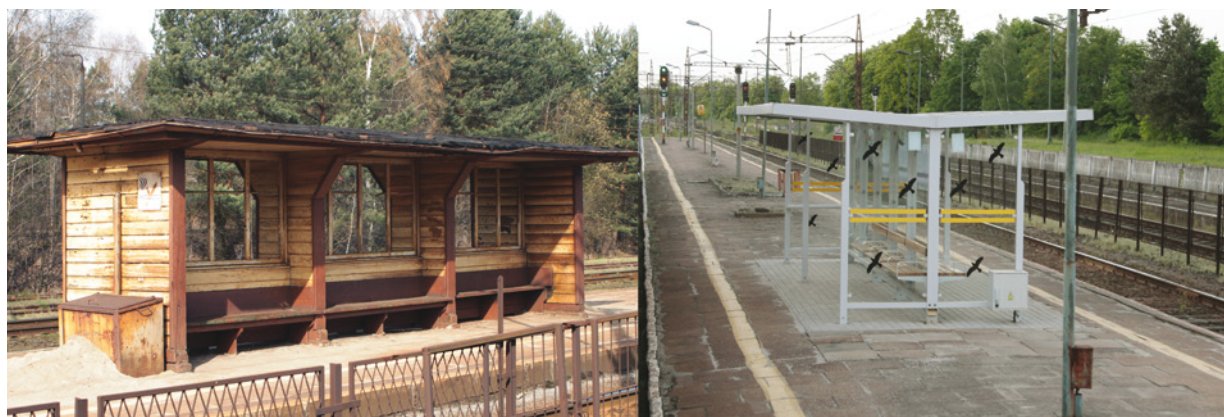
Il. 7. Grabowo Wielkie – historyczna wiata poczekalni peronowej zastąpiona nowoczesną konstrukcją (fot. M. Jerczyński)
