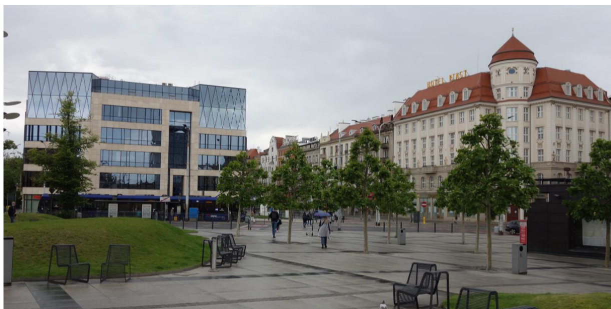
Il. 21. Zabudowa zachodniej części placu przed Dworcem Głównym PKP. Po lewej: Biurowiec Wrocław101 zaprojektowany przez PM Group Polska, po prawej: odrestaurowany Hotel Piast. Stan w 2020 r. (fot. P. Kirschke)
