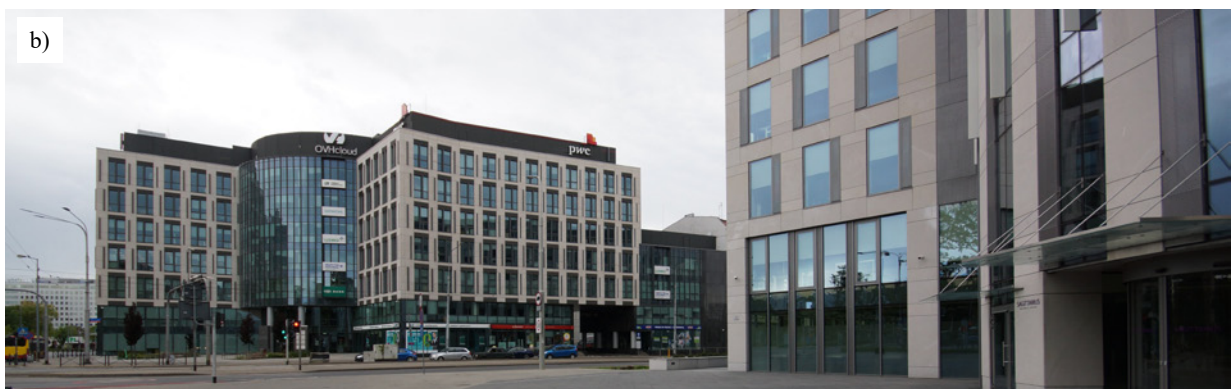
Il. 19. Zabudowa komercyjna przy ul. Suchej, powstała w latach 2013–2018; a) biurowiec Sagittarius Business House przy ul. Borowskiej 2 oraz galeria Wrocławia z dworcem autobusowym PKS na poziomie –2, b) biurowiec Aquarius Business House przy ul. Swobodnej 1 (fot. A. Krupa)
