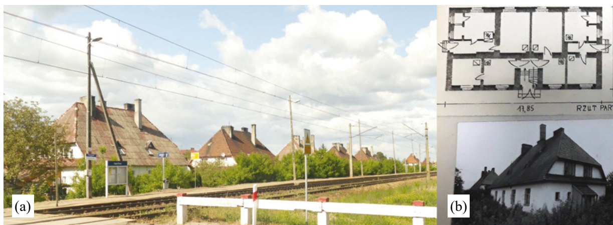
II. 11. Łapy Osse: (a) widok ogólny z planu kolejowego na zabudowę osiedla przy ul. Warszawskiej. Pierwotnie nasyp był niżej, budynki były niemal na poziomie torowiska, obecną niweletę wprowadzono w latach 50. XX w. Stan w 2020 r. (fot. A. Oleksicki), (b) rzut powtarzany w pozostałych obiektach parteru w tzw. białej karcie ewidencyjnej i widok ogólny budynku przy ul. Kolejowej 19. Stan w 1985 r. (oprac. A. Oleksicki na podstawie [4])
