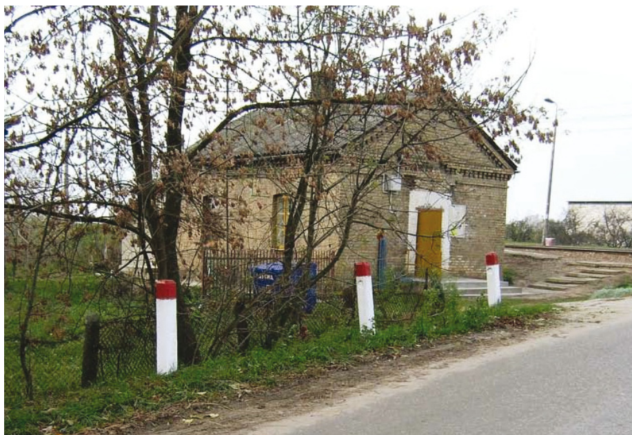
Il. 2. Jabłoń Kościelna – dawniej dróżniczówka na szlaku Łapy–Szepietowo, obecnie przystanek kolejowy. Budynek ze względu na rangę linii był murowany. Teren wokół, obecnie nieużytek, pełnił funkcję działki rolnej dróżnika. Stan w 2005 r. (fot. A. Oleksicki)
