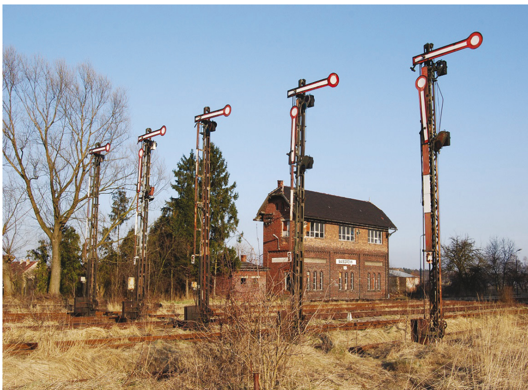
Il. 1. Sygnalizacja (semafory) kształtowa (Baborów). Stan w 2011 r. (fot. P. Mierosławski)
