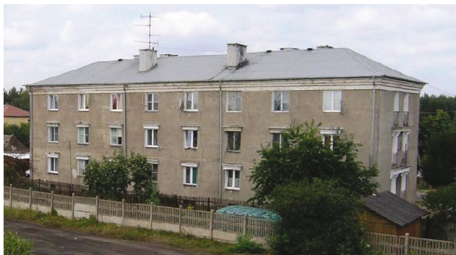
Il. 14. Czeremcha – widok z terenu nasycalni podkładów na trzykondygnacyjny, zorowski blok mieszkalny z lat 50. XX w., zbudowany według socrealistycznych kanonów. Z jego lewej strony widoczne są dwa rzędy komórek lokatorskich. Stan w 2006 r. (fot. A. Oleksicki)
