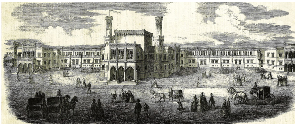
Il. 1. Stationsgebäude der Oberschlesischen und Breslau-Posen-Glogau Eisenbahn zu Breslau zaprojektowany w 1855 r. przez Wilhelma Grapowa [66]
