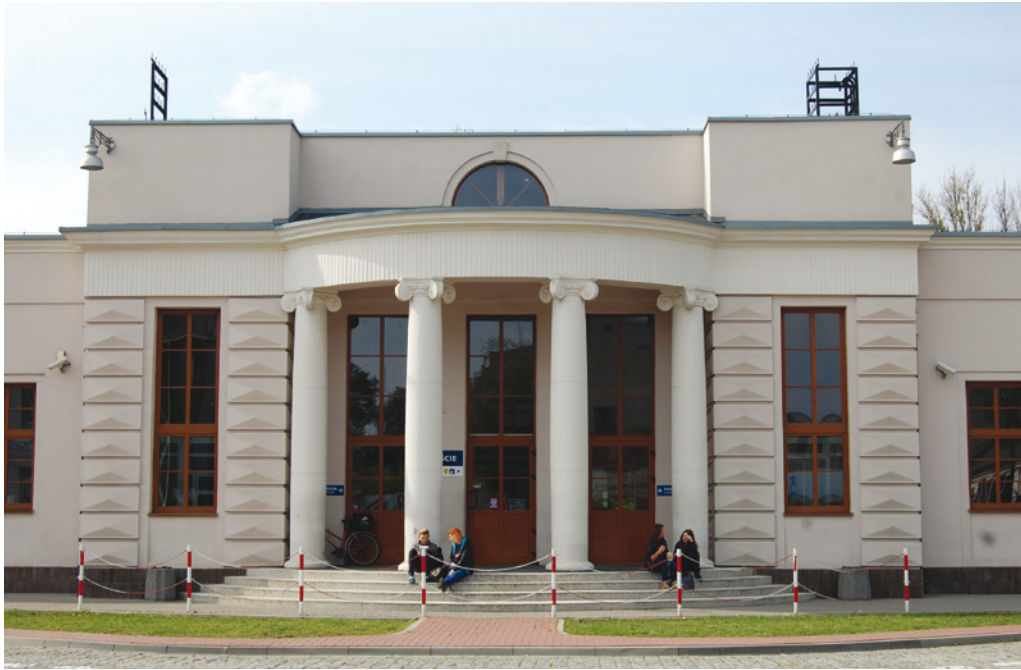
Il. 2. Dworzec kolejowy w Radomsku – przykład rozwiązań łączących stylistykę narodową i modernistyczną (fot. J. Krzyczkowski)
