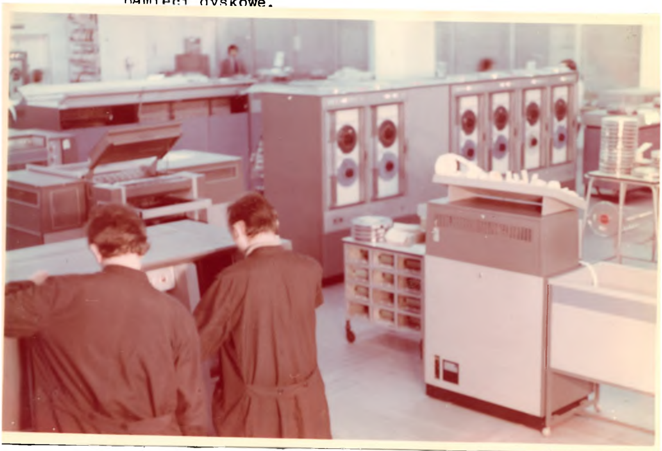
Fot. 12 Centralny Ośrodek Informatyki Górnictwa i Energetyki w Katowicach. Szafy z pamięciami taśmowymi.
