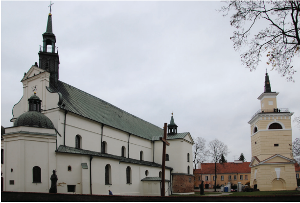
Il. 11. Przykładowe prace z dotacji MWKZ – Pułtusk, dzwonnica przy kolegiacie (1507 i 1786–1787), stan po pracach konserwatorskich (fot. W. Gołębiwska, 2019, ze zbiorów MWKZ)
