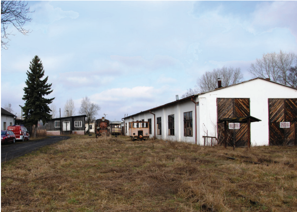
Il. 9. Mława, Mławska Kolej Dojazdowa, budynek lokomotywowni wąskotorowej, ul. Bracka 9A (przed 1918)
