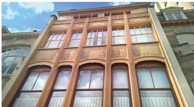
Il. 2. Żelazna konstrukcja i duże okna w oficjalnej części Hôtel van Eetvelde (fot. B. Widera)
