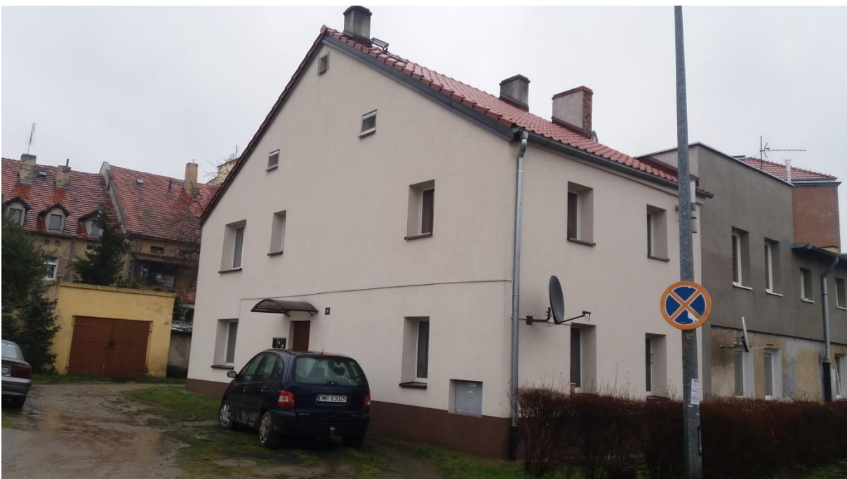
Fotografia 7 Kąty Wrocławskie, budynek mieszkalny przy ul. Kościuszki 14, źródło: zdjęcie własne
