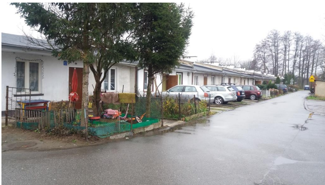
Fotografia 1 Kąty Wrocławskie, budynek mieszkalny przy ul. 1 Maja 47, źródło: zdjęcie własne
