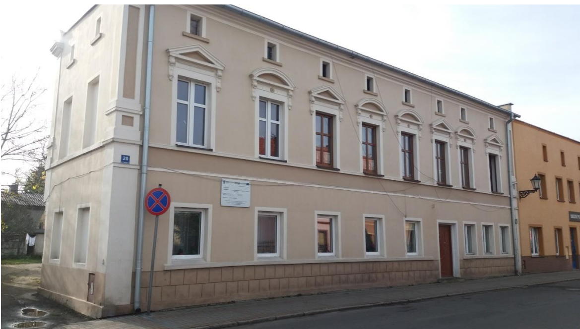
Fotografia 3 Chocianów, budynek mieszkalny przy ul. Kolejowej 20, źródło: zdjęcie własne
