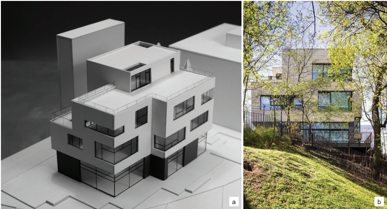
Il. 2. Dom na skarpie przy ul. Morskie Oko w Warszawie (2015) autorstwa Grupa 5 Architekci: a) makieta, b) budynek (zdjęcie makiety: archiwum Grupa 5 Architekci; zdjęcie budynku: M. Czechowicz)
