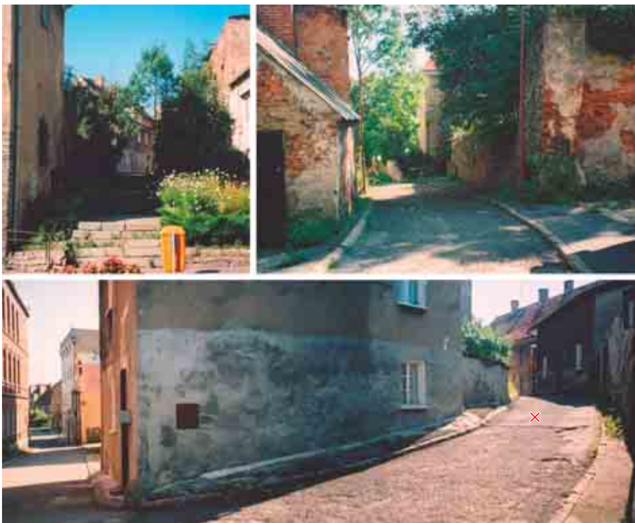
Il. 4. Niemcza. Widoki na kulminacyjne wzgórze ul. Podmiejskiej ze schodami od ul. Bolesława Chrobrego (krzyżykiem oznaczono miejsce starego wału)
