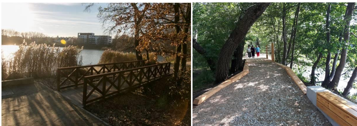
Ryc. 127 (a-b). Wybrane zadania realizowane w stylu naturalistycznym po 2010 r.: zagospodarowanie wokół zbiornika wodnego przy ul. Głównej pn. „Nowa Cegielnia Stabłowicka” oraz BioPark Doliny Ślęży w Lesie Pilczyckim. Fot. mat. arch. UMW, źródło: www.wroclaw.pl , dostęp: 2020.
