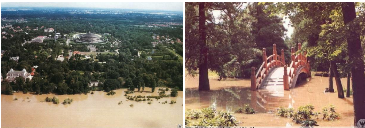
Ryc. 106 (a-b). Zasięg wody w Parku Szczytnickim podczas powodzi w lipcu 1997 r.
