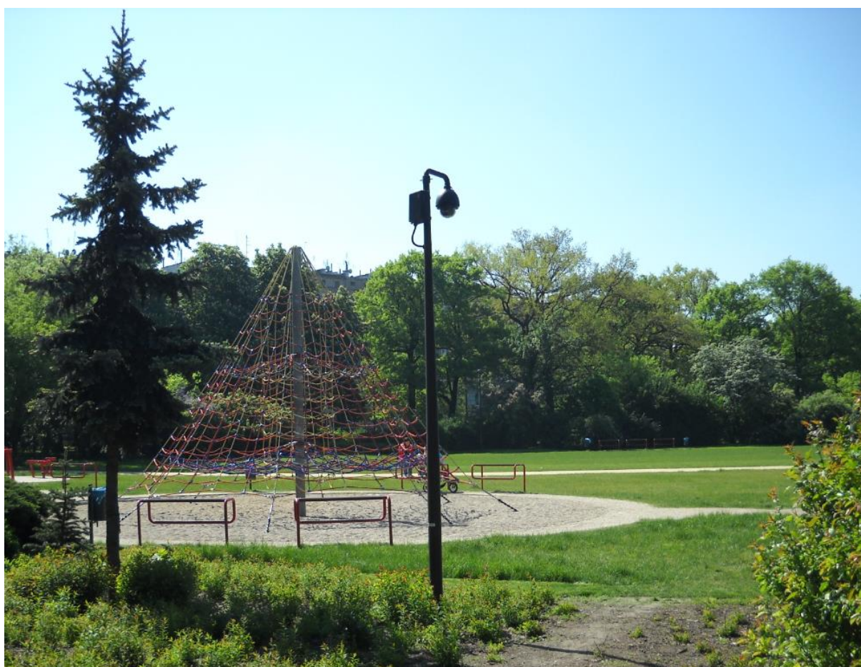
Ryc. 122. Monitoring wizyjny zainstalowany w ramach rewitalizacji parku im. S. Staszica na osiedlu Nadodrze we Wrocławiu. Fot. S. Rozalski 2013.
