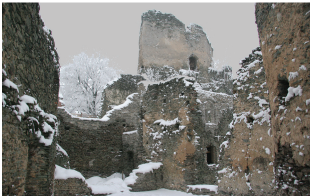
Il. 1. Widok ruin zamku z wnętrza drugiej kondygnacji późnogotyckiego domu zamkowego (fot. M. Chorowska)
