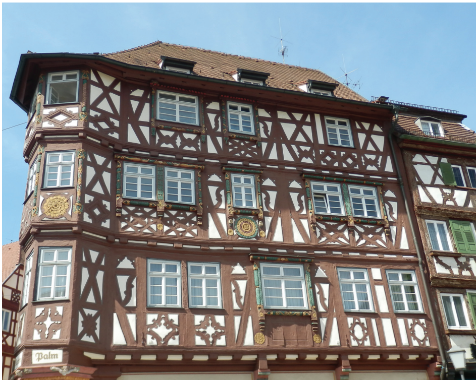
Il. 2. Palm'sche Haus w Mosbach z widocznymi „przesztynieniami” – dodawane belki były zbędne z punktu widzenia konstrukcyjnego, podnosiły jedynie dekoracyjność kratownicy (fot. D. Kowalska)
