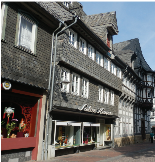
Il. 5. Goslar – łupek na elewacji maskujący drewnianą konstrukcję szkieletową (fot. D. Kowalska)
