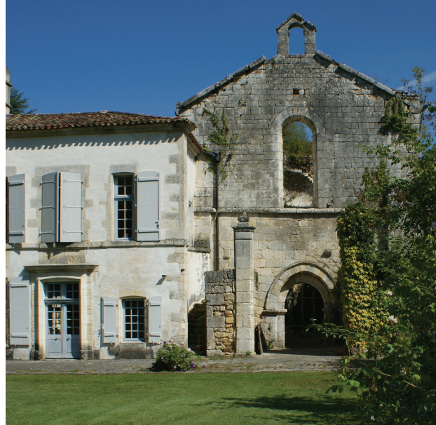
Il. 4. Elewacja zachodnia kościoła w Grosbot, 2012 (fot. E. Łużyniecka) Fig. 4. Western facade of the church in Grosbot, 2012 (photo by E. Łużyniecka)
