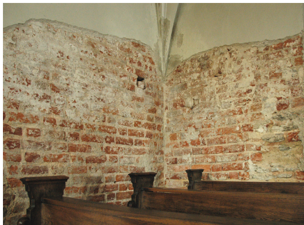
Il. 6. Opole – katedra, wewnętrzny narożnik południowo-zachodni korpusu i wieży
