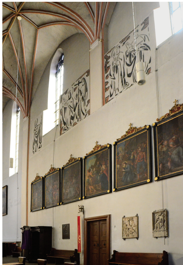
Il. 7. Opole – katedra, ściana południowa korpusu za zmianami grubości
