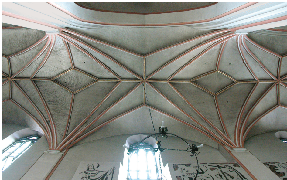
Il. 12. Opole – katedra, obniżone sklepienie nad nawą południową Fig. 12. Opole – cathedral, lower vault above the south aisle
