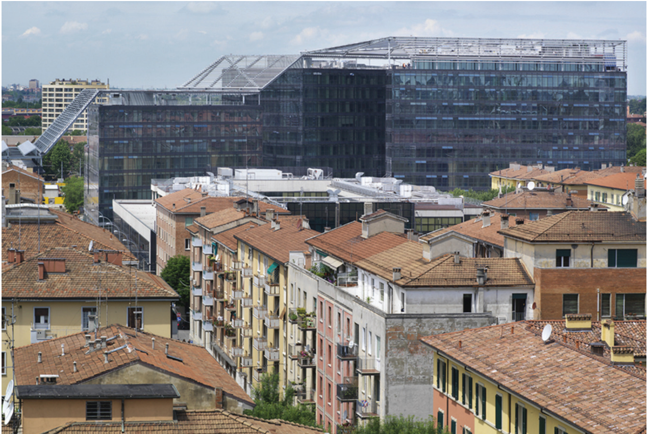
Il. 2. Siedziba Rady Miejskiej w Bolonii, Mario Cucinella Architects, 2008, widok od wschodu. Nowy obiekt administracyjny jest wyraźnie zauważalny w tkance miejskiej, zaś jego lokalizacja przyczyniła się do podniesienia standardu całej dzielnicy. Fot. Daniele Domenicali, MCA Archive © Mario Cucinella Architects
