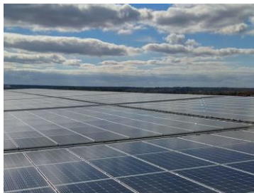
Rys. 5. Montaż paneli fotowoltaicznych [2].
