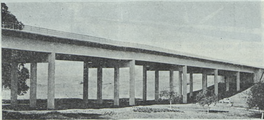
Ryc. 15. Wiadukt pod Denkendorf.
