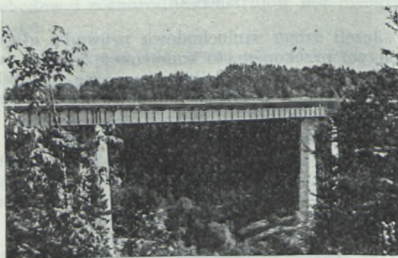
Ryc. 16. Wiadukt w dolinie rzeki Mangfall.
