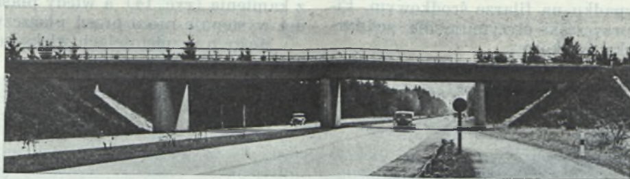
Ryc. 7. Przejazd górą na drodze samochodowej Monachium-Salzburg.
