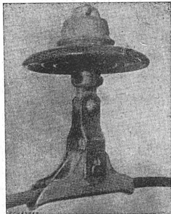
Rys. 33. Przykład właściwej konstrukcji zacisku
