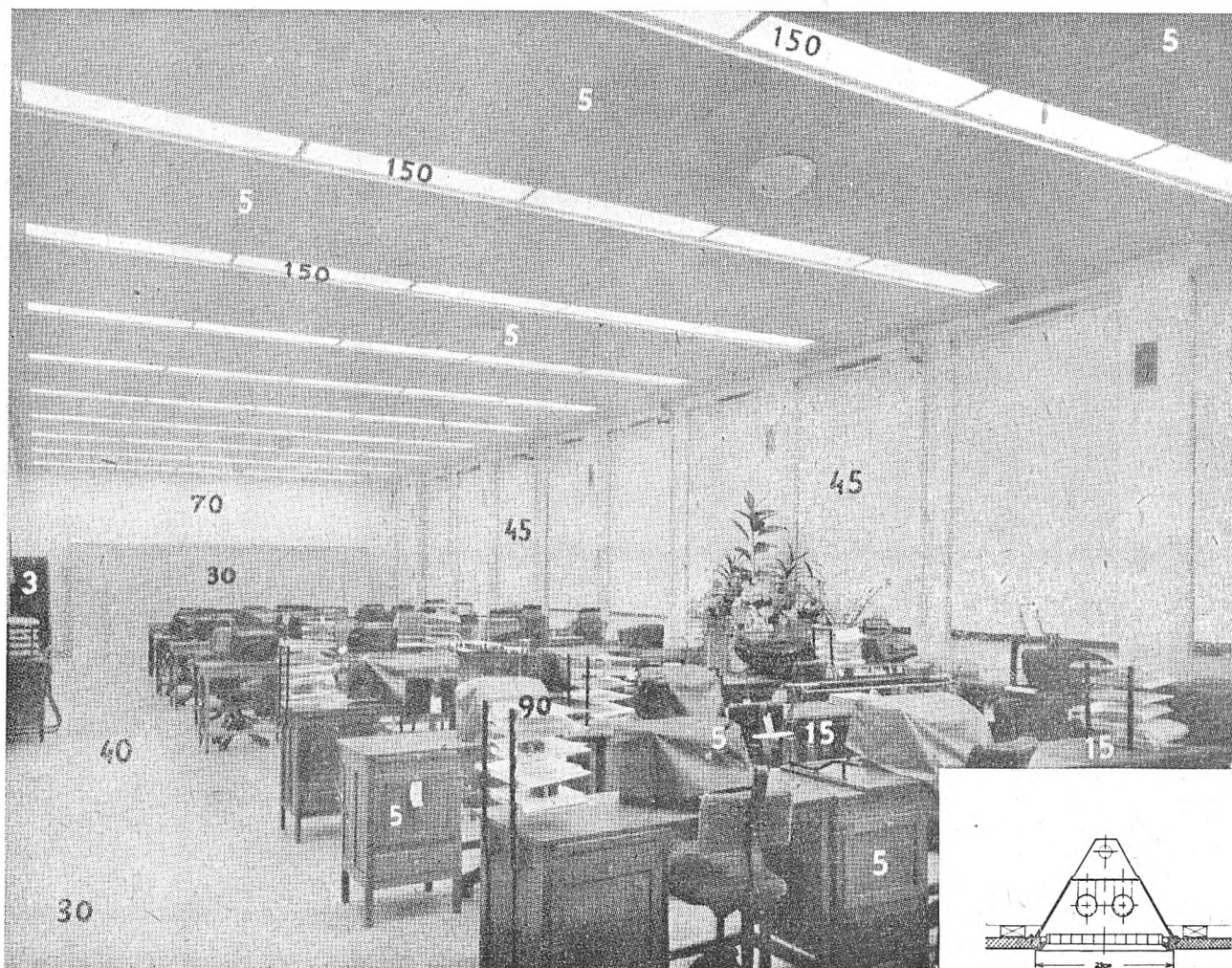
Rys. 5. Przykład oświetlenia biura Srednie natężenie oświetlenia ok. 350 lx Duża równomierność jasności (podanej w cd/m 2 ) w całym wnętrzu
