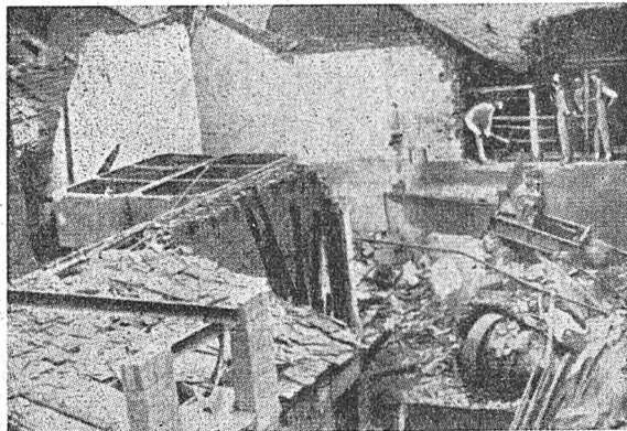
Rys. 1. Skutki wybuchu pyłu palnego
