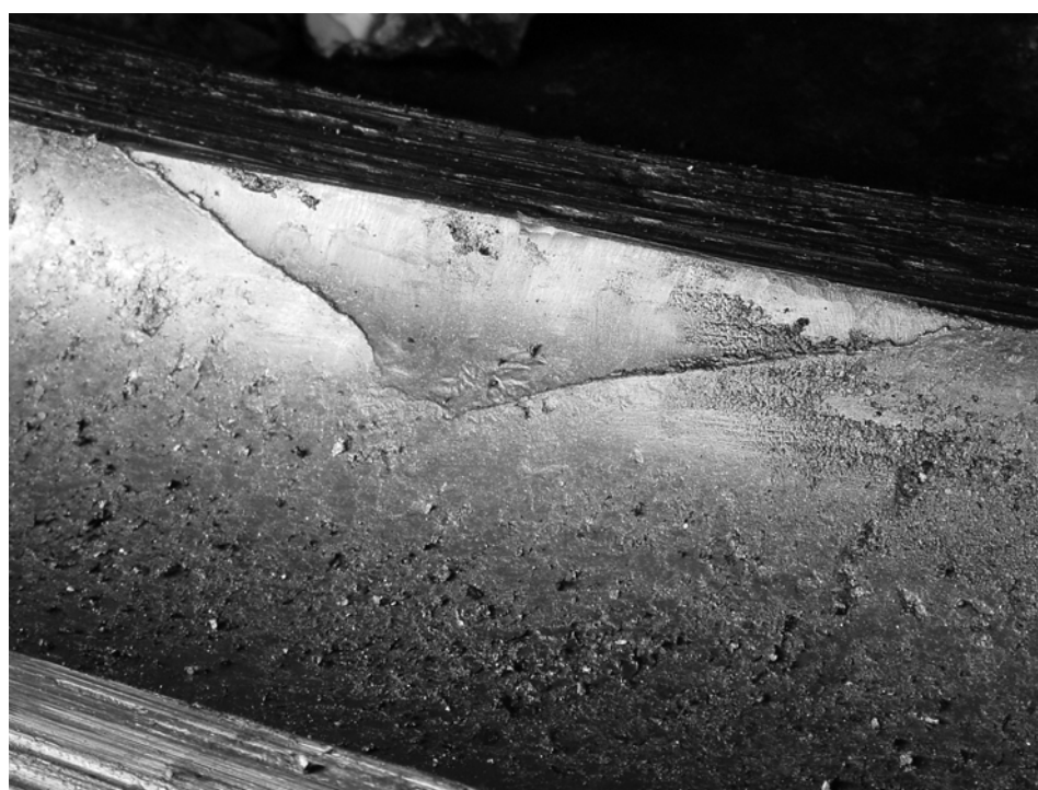
Rys. 10.52. Rozwalcowanie bieżni – widoczne wypłynięcia materiału
