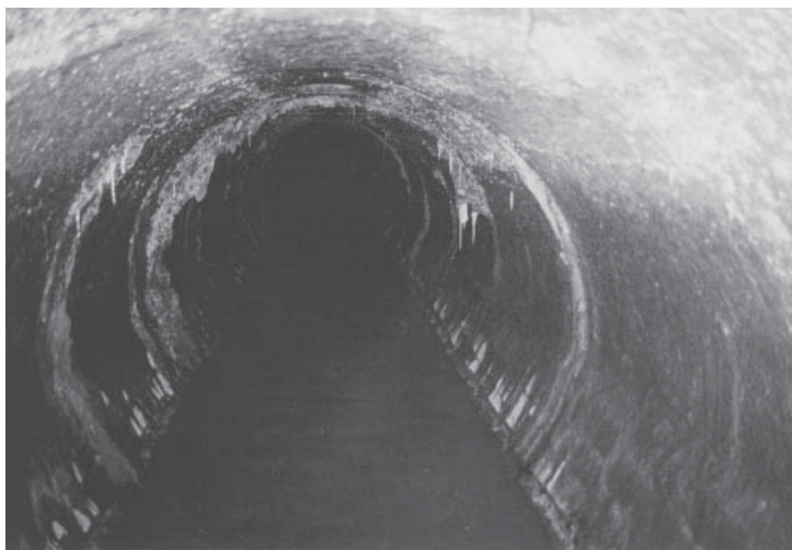
Rys. 5.20. Widok wnętrza kolektora „Śleza” przed odnową
