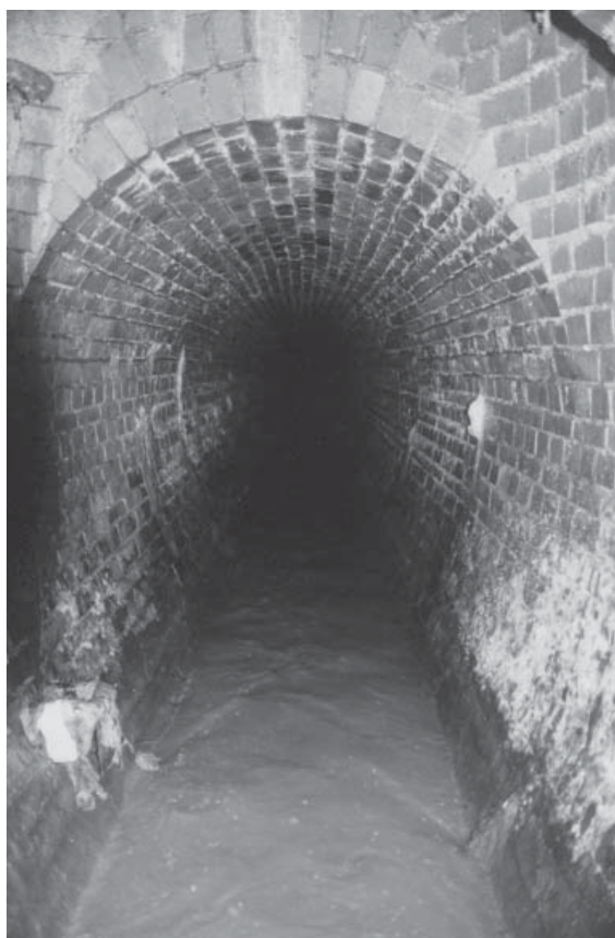
Rys. 5.21. Widok wnętrza ceglanego kolektora pod ul. Nowy Świat we Wrocławiu
