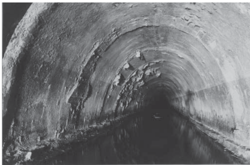
Rys. 5.19. Widok wnętrza kolektora „Odra” przed odnową
