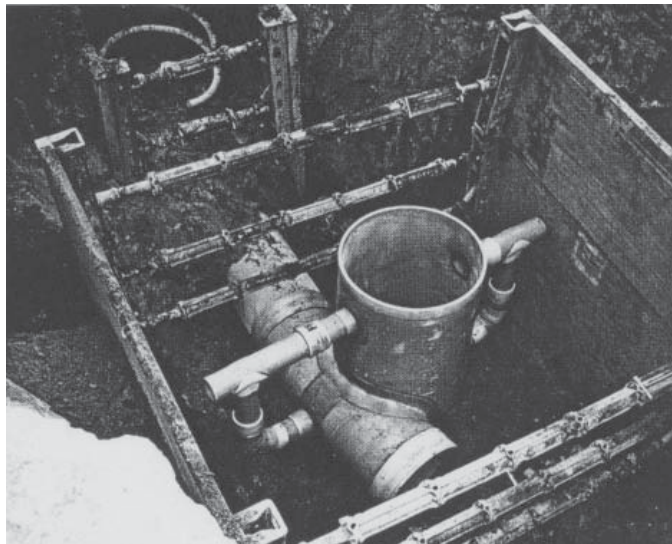
Rys. 6.3.7. Rozwiązanie konstrukcyjne studzienki z żywic poliestrowych wzmocnianych włóknem szklanym, produkcji firmy HOBAS
