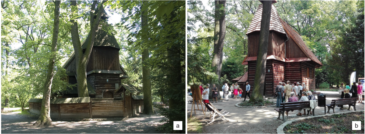
Fig. 4. Wrocław, St. John of Nepomuk Church in Szczytnicki Park: a) before renovation in 2009, b) after renovation in 2018 (photo by S. Rozalski) Il. 4. Wrocław, kościółek pw. św. Jana Nepomucena w parku Szczytnickim: a) przed remontem w 2009 r., b) po remoncie w 2018 r. (fot. S. Rozalski)
