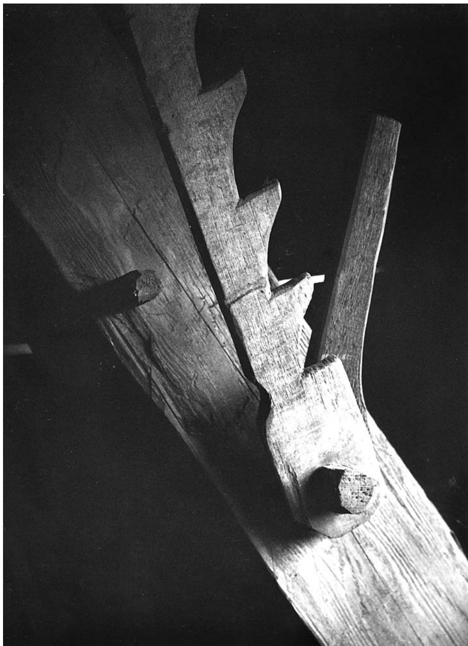
25. Duszniki – Papiernia – Suszarnia – podpory klapy wietrznika. Fot. K. Gawinowska X. 1960 r. Neg. P.K.Z. – Wrocław
