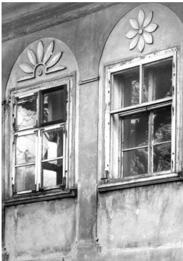
20. Duszniki – Papiernia – Okna elewacji północnej [zachodniej]. Fot. K. Gawinowska X. 1960 r. Neg. P.K.Z. – Wrocław
