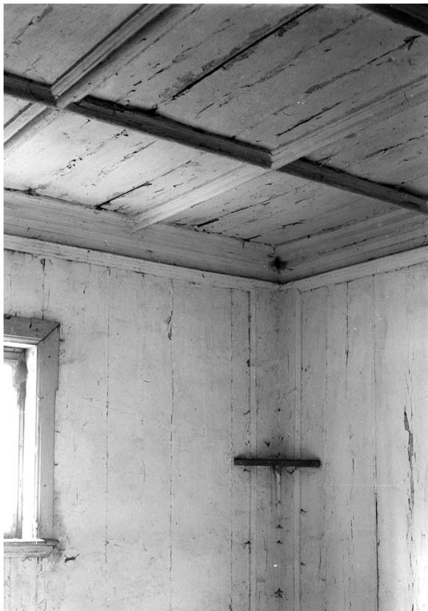
22. Duszniki – Papiernia – Wnętrze izby III kondygnacji. Fot. K. Gawinowska X. 1960 r. Neg. P.K.Z. – Wrocław
