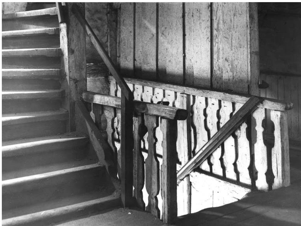
21. Duszniki – Papiernia – Klatka schodowa. Fot. K. Gawinowska X. 1960 r. Neg. P.K.Z. – Wrocław
