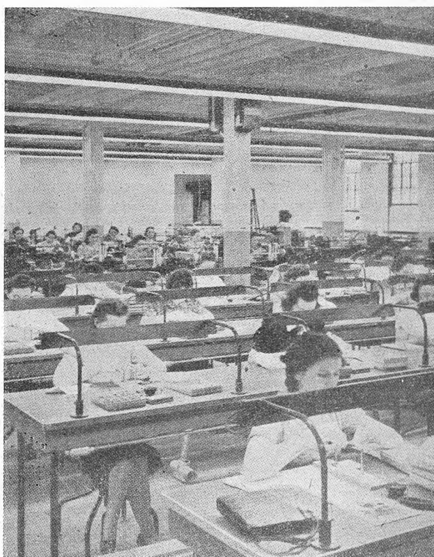
Rys. 7. Oświetlenie ogólne oraz dodatkowe miejsc pracy przy pomocy lamp fluoryzujących Praca dokładna i trwająca nieprzerwanie, wymagająca dużej jasności w miejscu pracy oraz prawidłowego rozkładu jaskrawości w polu widzenia pracujących
