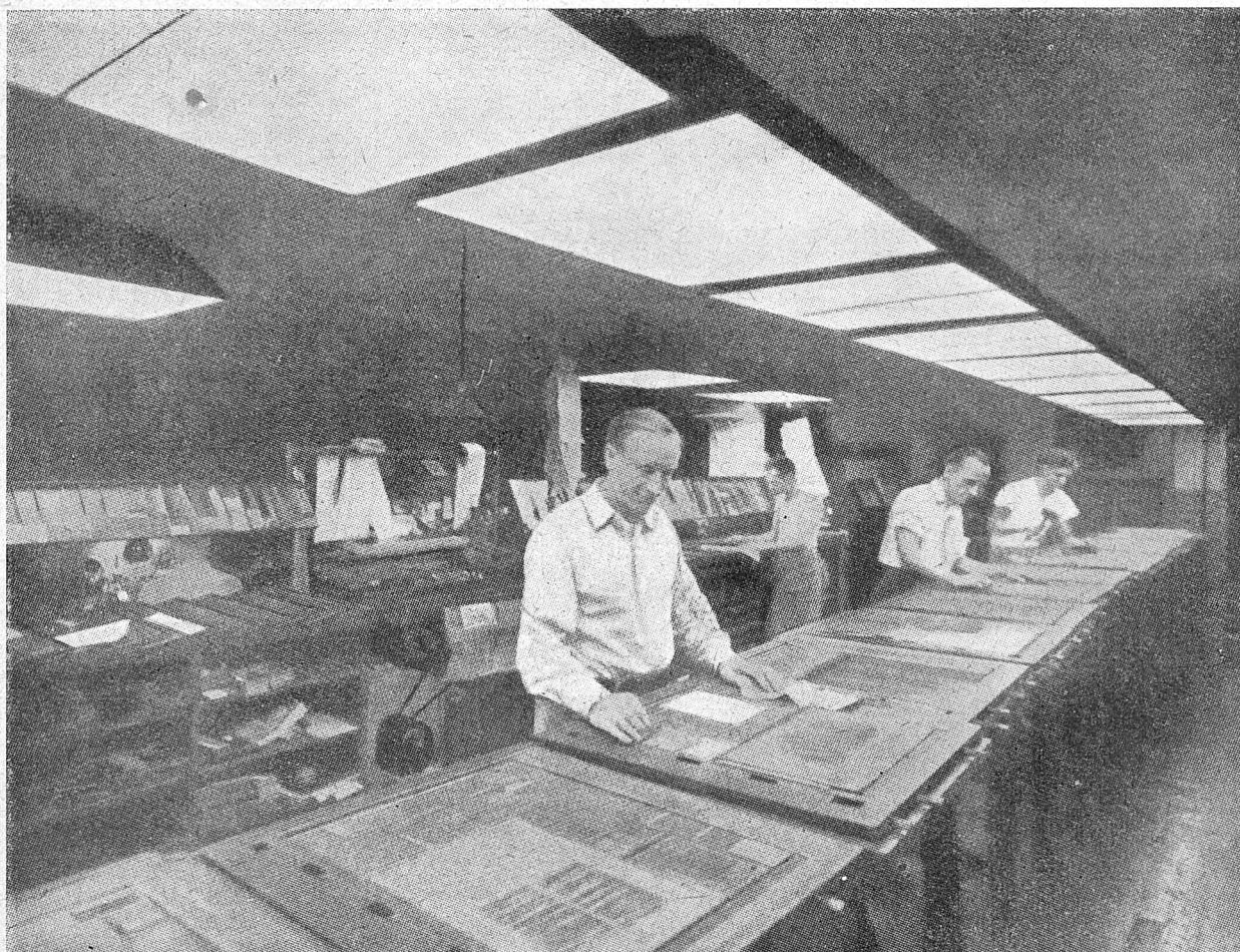
Rys. 5. Oprawy skrzynkowe o dużej powierzchni świecącej z 2 żarówkami po 200 W zakryte szybą mleczną Średnia jasność na stołach zecerskich 600 lx
