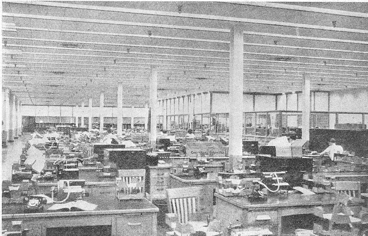
Rys. 8. Sala biurowa; odległość między rzędami 1,3 m; dodatkowe lampy z lewej strony kompensują stratę przez okna
