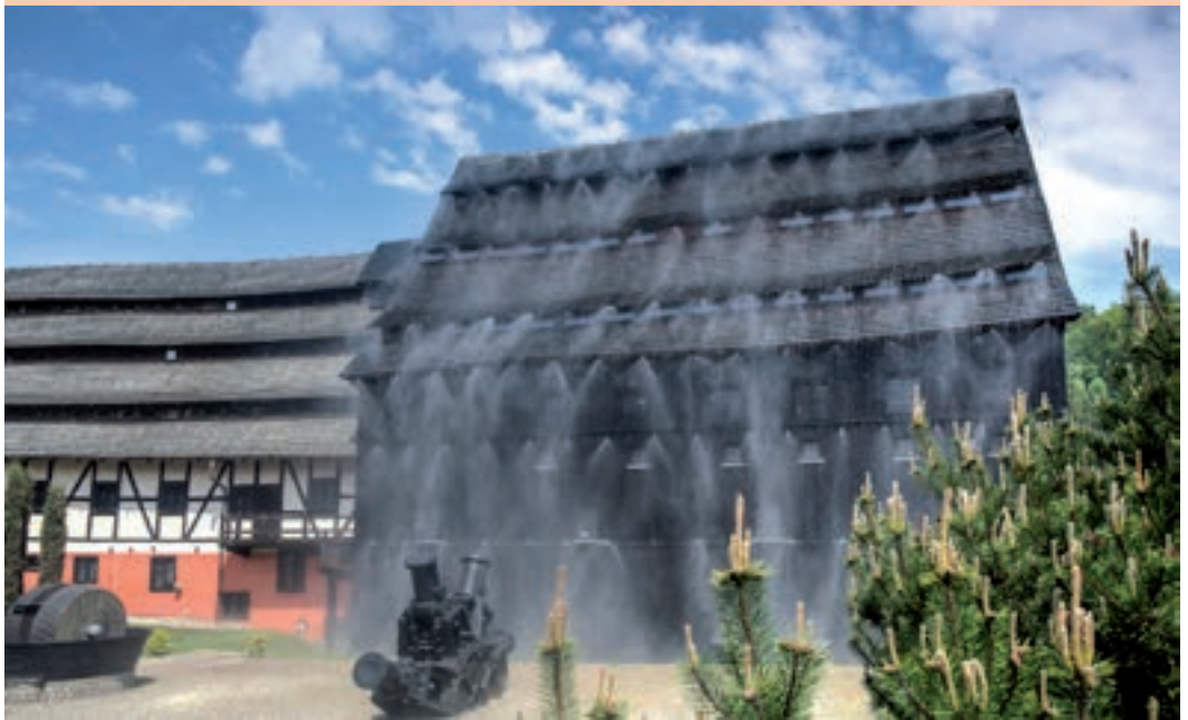
Oddanie do eksploatacji systemu gaszenia mgłą, 2017 r.
