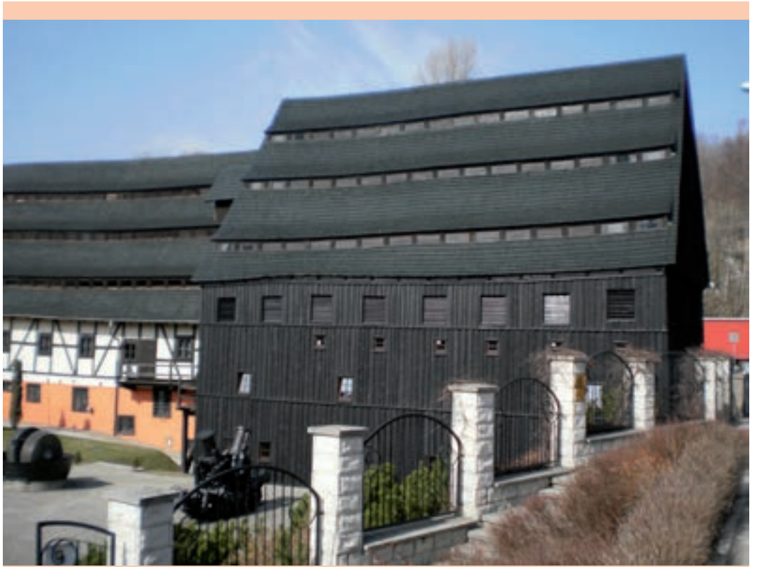
Budynek suszarni od strony południowej
