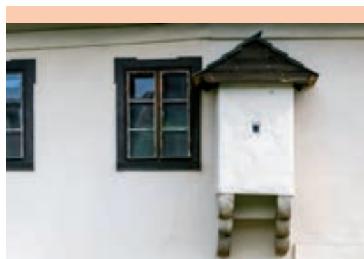
Wykusz latrynowy w elewacji południowej młyna
