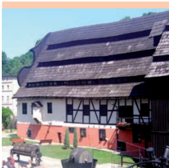
Południowa ściana szachulcowa
