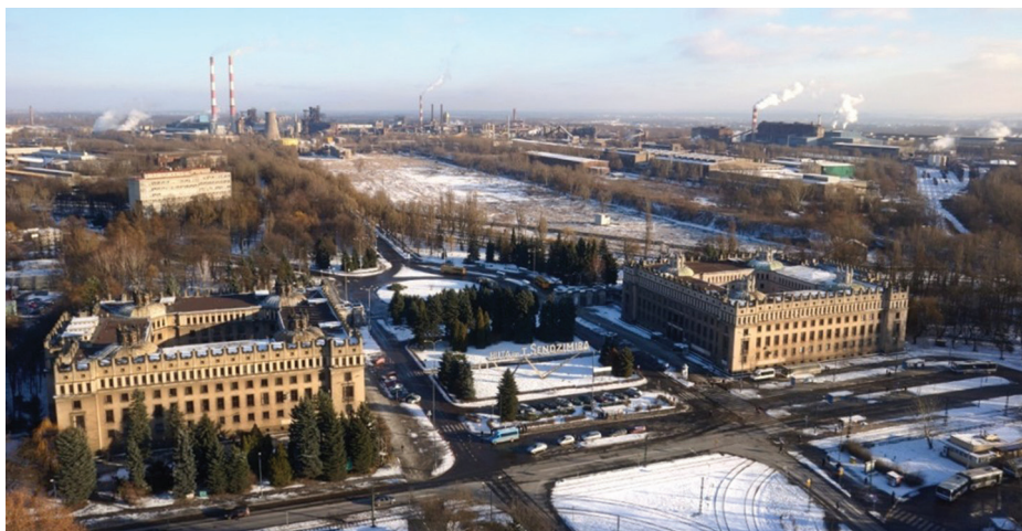
Fot. 14.2. Centrum Administracyjne Huty im. Lenina, Kraków – Nowa Huta
