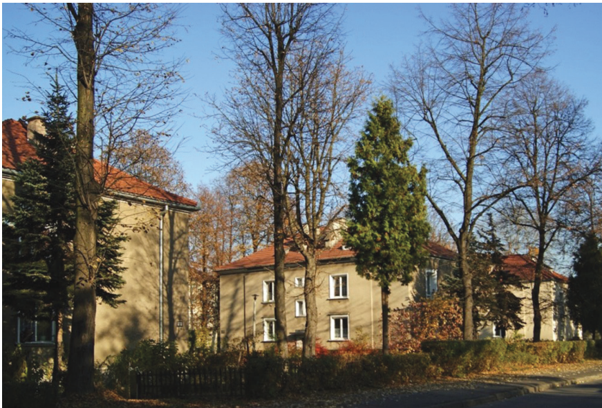
Fot. 14.3. Pierwsze budynki mieszkalne w Nowej Hucie
