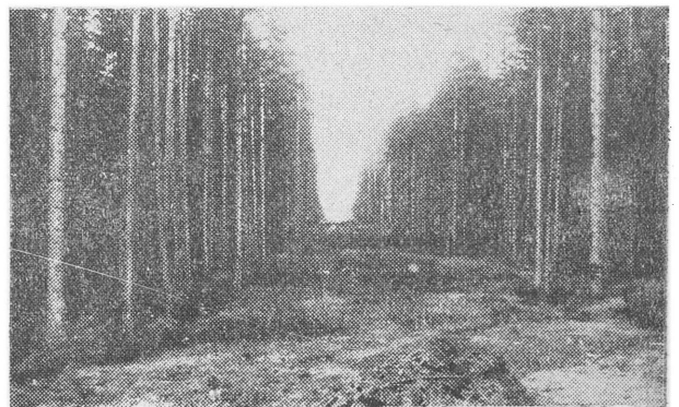
Rok 1943 — część trasy kolejki linowej, z pozostałymi po podporach kolejki, śladami fundamentów.
