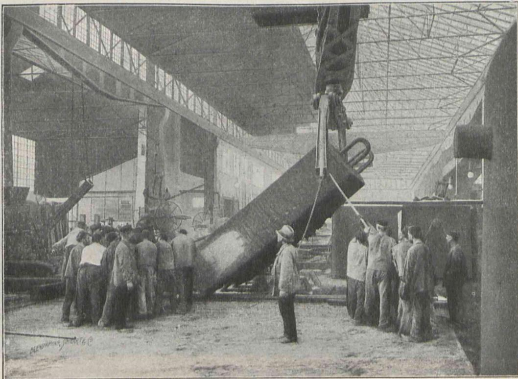
Herausziehen des Gussblockes aus der Giessgrube.
