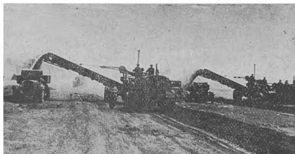
Rys. 5. Zastosowanie ciężkich ciągników gąsienicowych do robót ziemnych w Związku Radzieckim.
