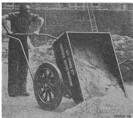
Rys. 2. Specjalny wózek do przewożenia materiałów sypkich.
