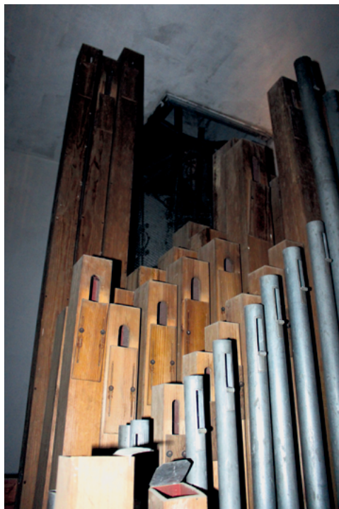
Fotografia 24. Piszczalki manualu II i pedału organów w Smolicach. Fot. T. Sowiński
