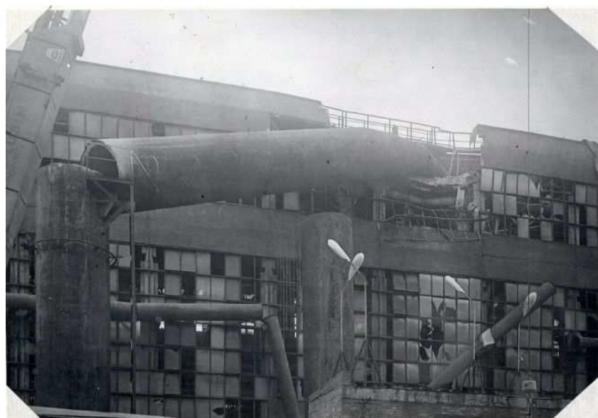
Rys. 1. Przykład katastrofy budowlanej komina Fig. 1. An example of chimney crash
