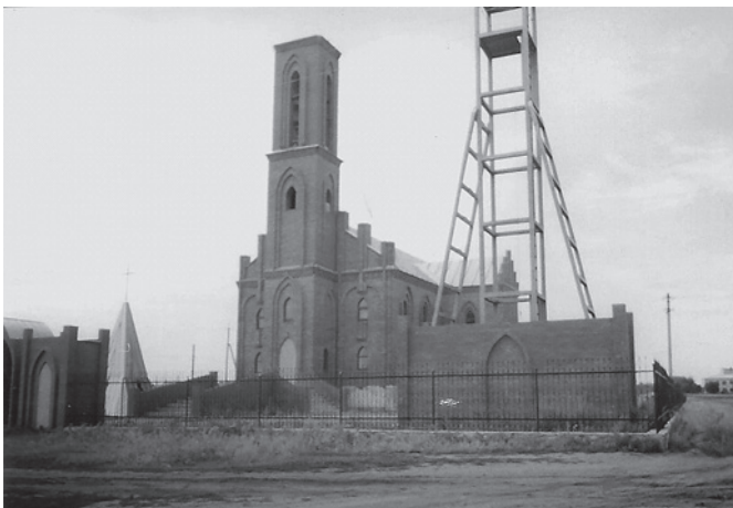
Fot. 21. Budowa kościoła w Czkałowie
