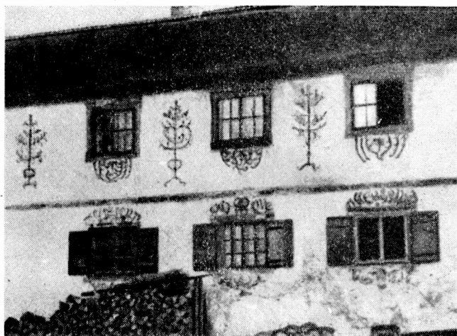
Ryc. 19. Malatury na ścianie domu bawarskiego.
