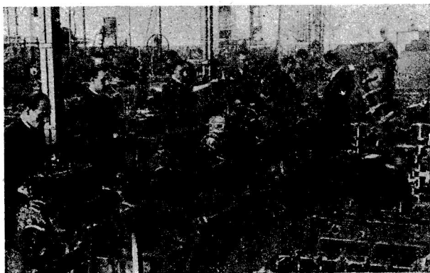
Rys. 7. Linia składania silników w fabryce o produkcji 1 silnika na godzinę
