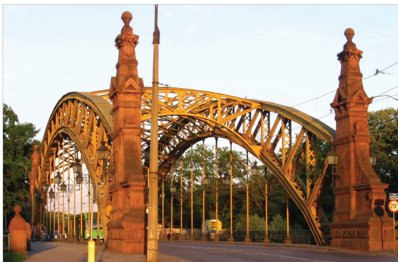
Fot. 18.12. Most Zwierzyniecki od strony miasta (od północnego zachodu)
