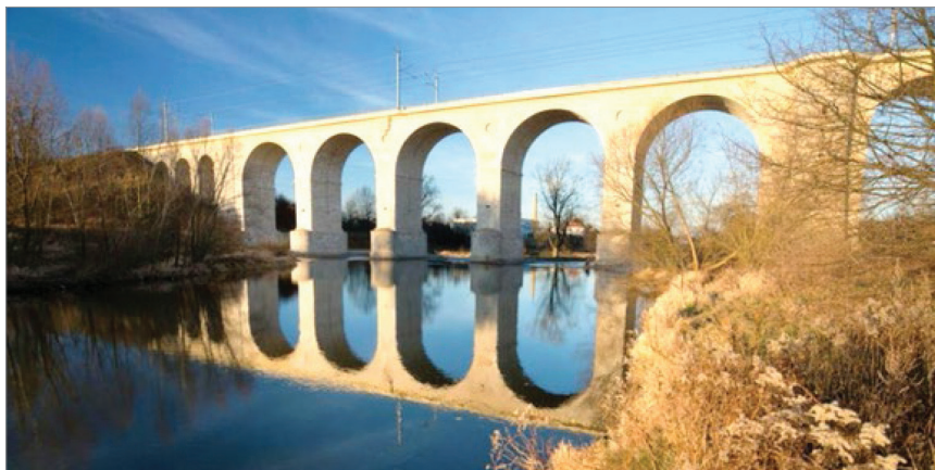
Fot. 18.21. Wiadukt kolejowy w Bolesławcu
