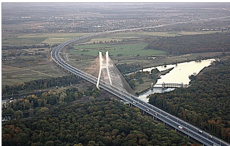
Fot. 18.15. Most Rędziński – widok z lotu ptaka
