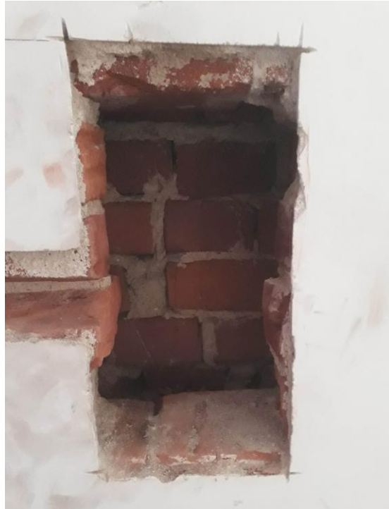
Zdjęcie 14 Konstrukcja ściany zewnętrznej budynku, w którym wykonano stanowisko pomiarowe (udostępnione przez właścicieli budynku)
