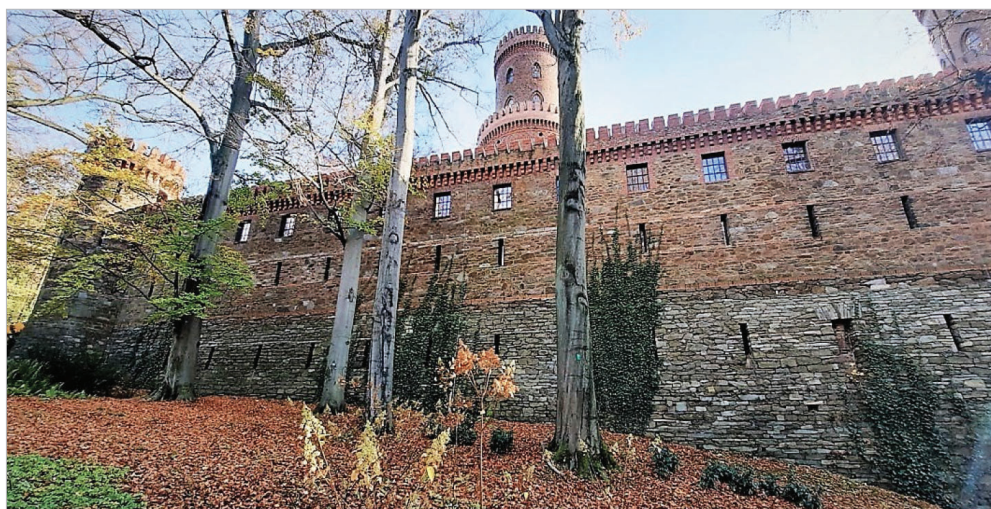
Fot. 16.14. Oficyna północna pałacu z wozownią
