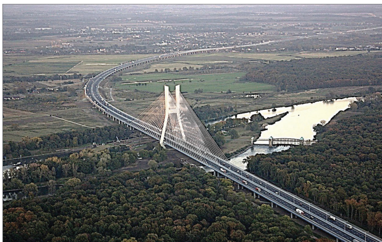
Fot. 18.15. Most Rędziński – widok z lotu ptaka
