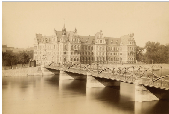
Fot. 18.9. Nieistniejący obecnie most Lessinga, ok. 1886 rok
