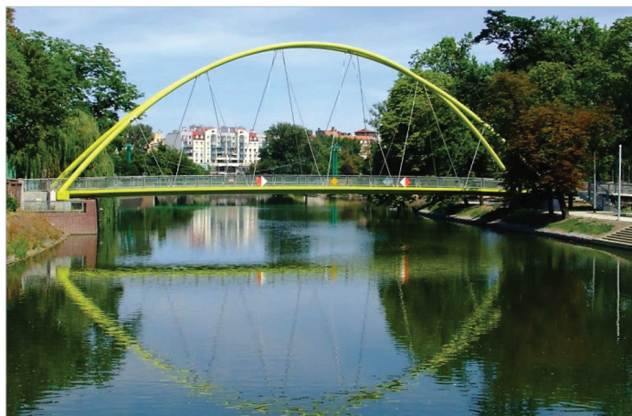
Fot. 18.7. Kładka Słodowa – kładka piesza łącząca Wyspę Słodową z terenem osiedla Nadodrze Photo 18.7. Słodowa Footbridge – a footbridge connecting the Słodowa Island with the area of the Nadodrze estate
