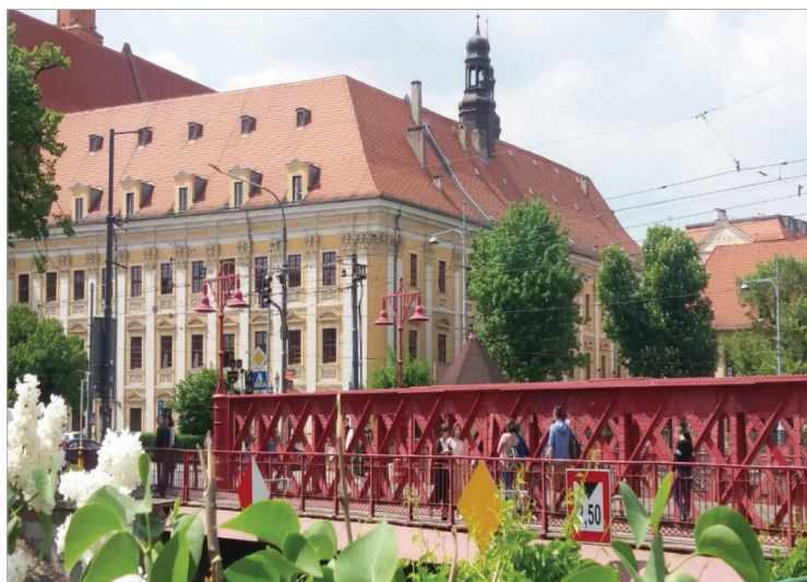
Fot. 18.1. Most Piaskowy – widok od strony wschodniej (z Bulwaru Piotra Włostowica)
