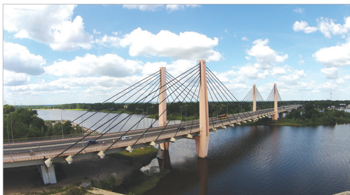
Fot. 18.13. Most Milenijny od wschodu
