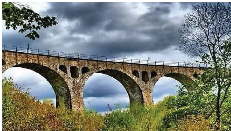
Fot. 18.19. Wiadukt w Lewinie Kłodzkim
