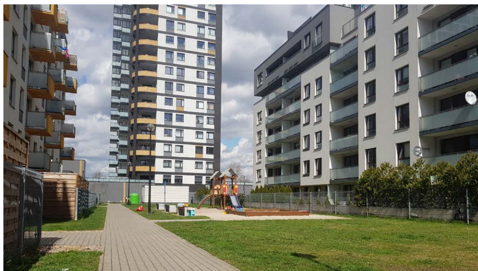
Il. 14. Zagospodarowanie terenu nad parkingiem podziemnym, ul. Jesionowa, Wrocław, fot. A. Szumilas
