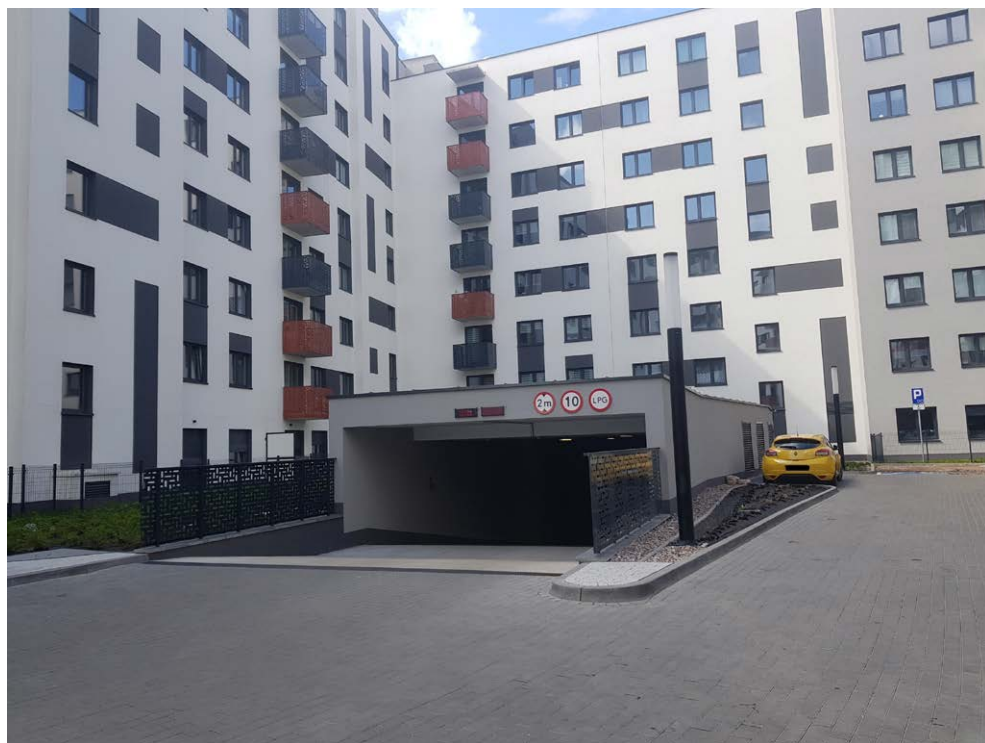
Il. 15. Wjazd do garażu podziemnego, ul. Kamienna, Wrocław; fot. A. Szumilas
