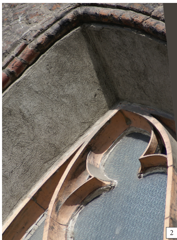
72. Okno w środkowym prześle południowej nawy bocznej: 1 – oścież i maswerk, 2 – betonowy odlew wypełnienia łuku, stan z 2007 r. (fot. E. Łuzyniecka)
