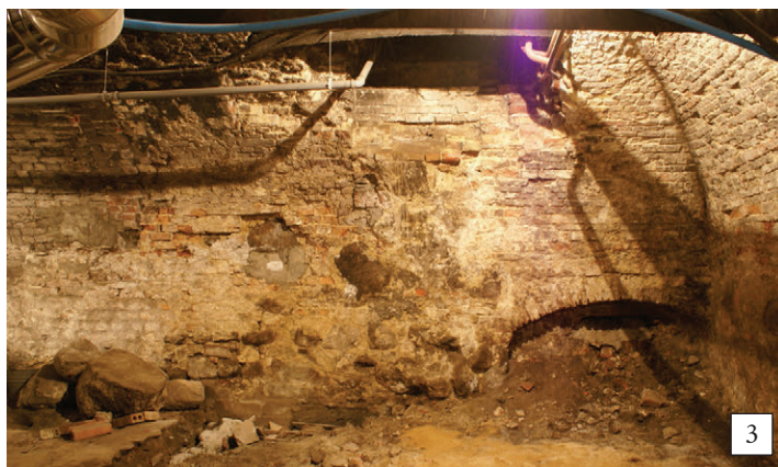
116. Ściana zachodnia kotłowni:
