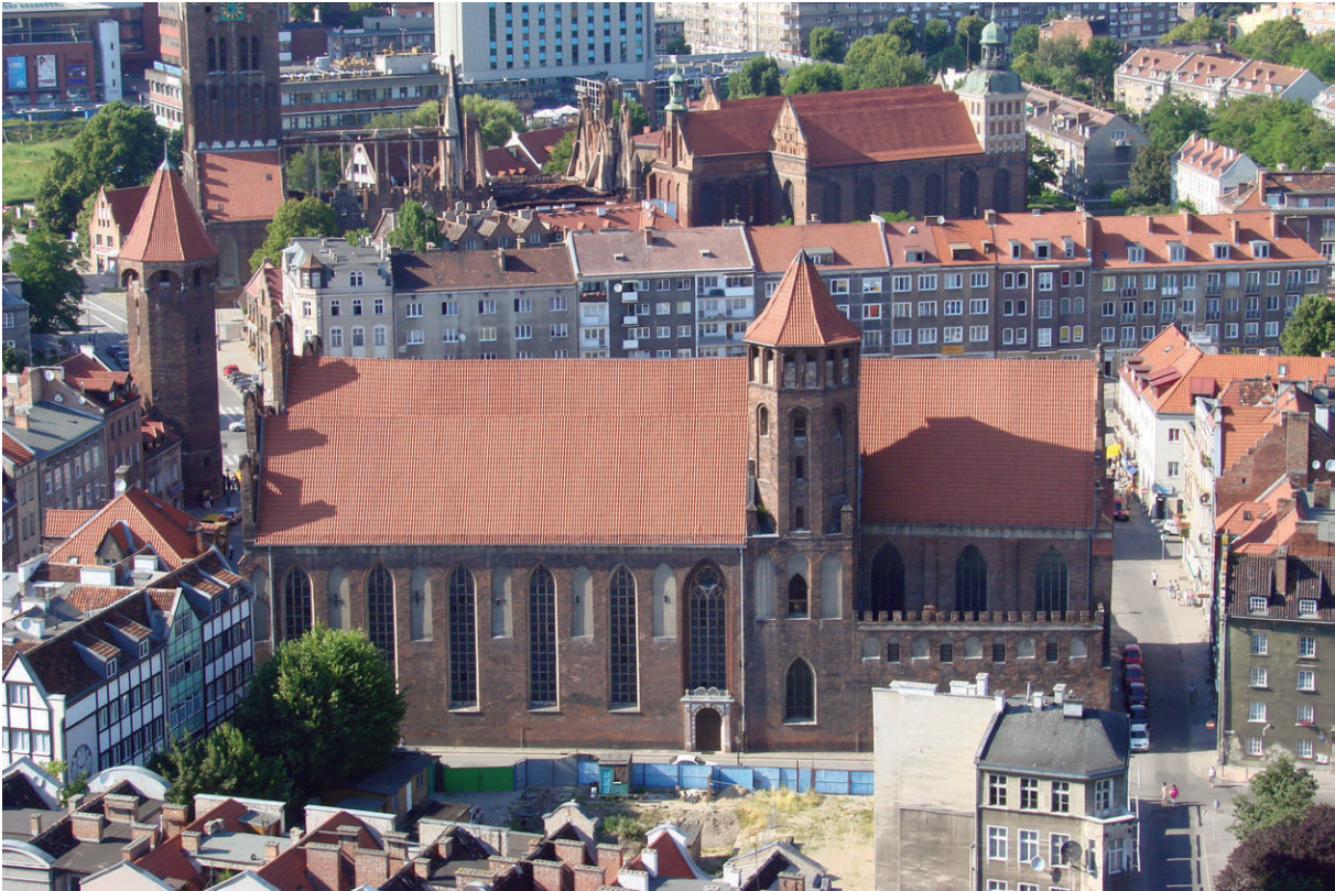
37. Kościół św. Mikołaja i jego otoczenie od strony południowej, widok z wieży kościoła Mariackiego, stan z 2004 r. (fot. E. Łużyniecka)
