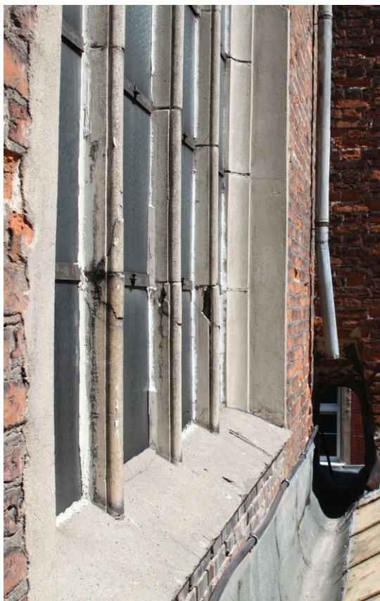
63. Wyprowadzenie betonowych lasek maswerku wschodniego okna w południowej ścianie prezbiterium, stan z 2010 r. (fot. E. Łużyńska)
