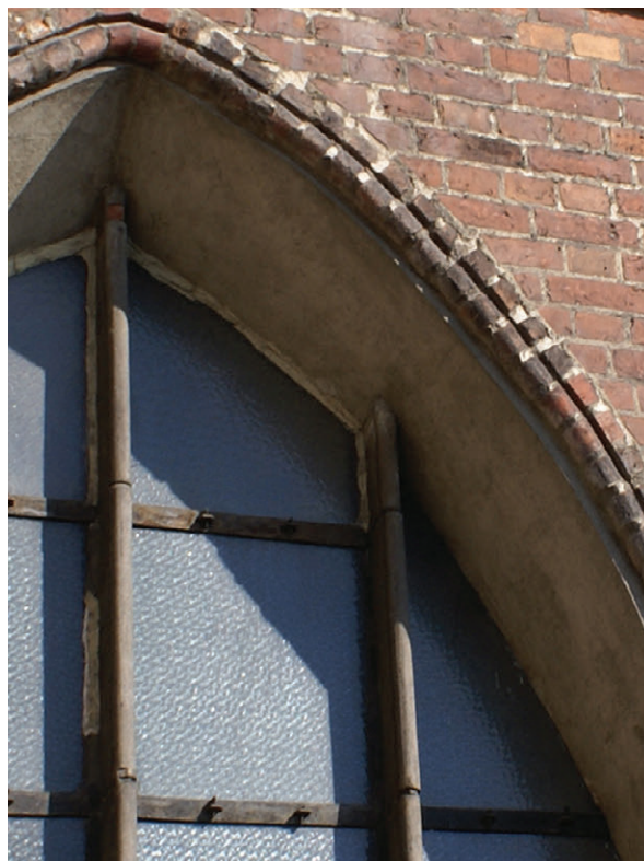
62. Wypełnienie łuku wschodniego okna w południowej ścianie prezbiterium, stan z 2010 r. (fot. E. Łużyniecka)
