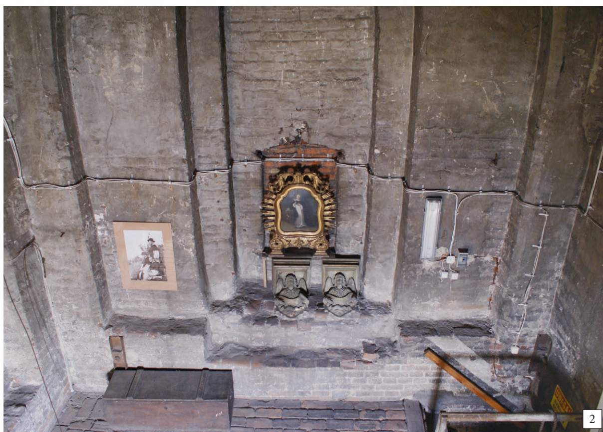
171. Ściana północna drugiej kondygnacji wieży, stan z 2004 r.: 1 – trompy w części górnej, 2 – budowa ściany (fot. E. Łuzyniecka)
