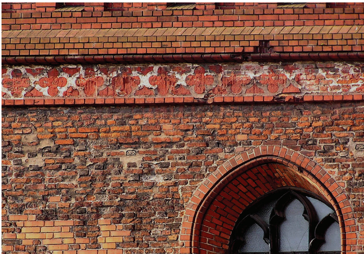
93. Gzyms plyninowy z relikdami polichromii, stan z 2010 r. (fot. E. Łużyńska)
