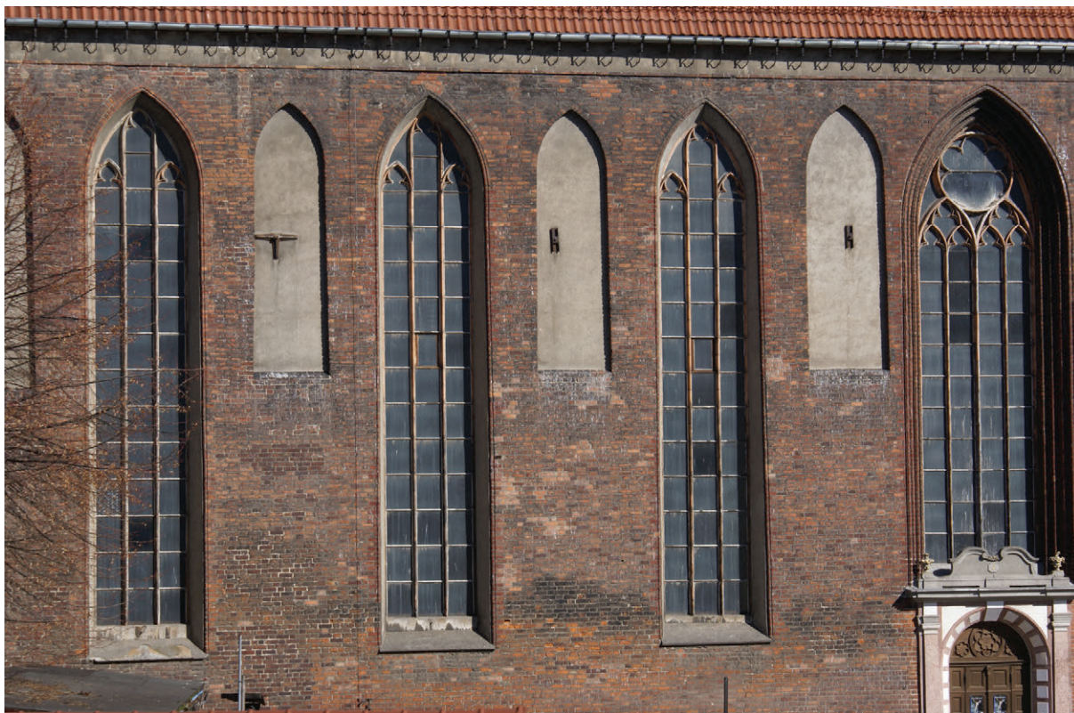
71. Okna i płyciny w ścianie południowej nawy bocznej, stan z 2007 r. (fot. E. Łuzyniecka)
