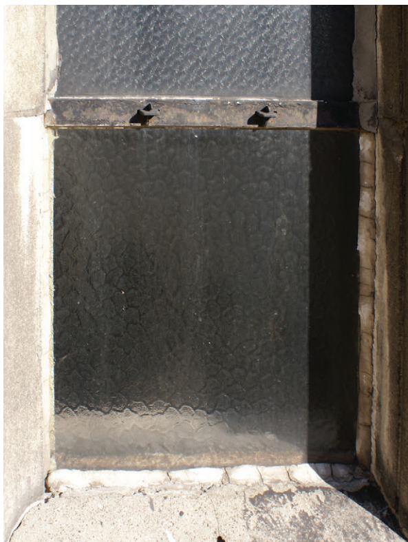
61. Oszklenie środkowego okna w południowej ścianie prezbiterium, stan z 2010 r. (fot. E. Łużyniecka)
