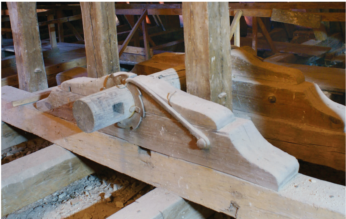
200. Budowa południowej części dźwigu budowlanego (patrz 196.B), stan z 2007 r. (fot. E. Łużyńska)
