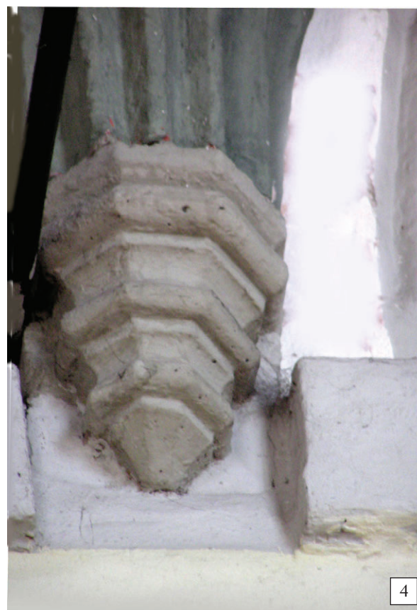
159. Wsporniki o profilach uskokowych w nawach bocznych, stan z 2006 r.:
