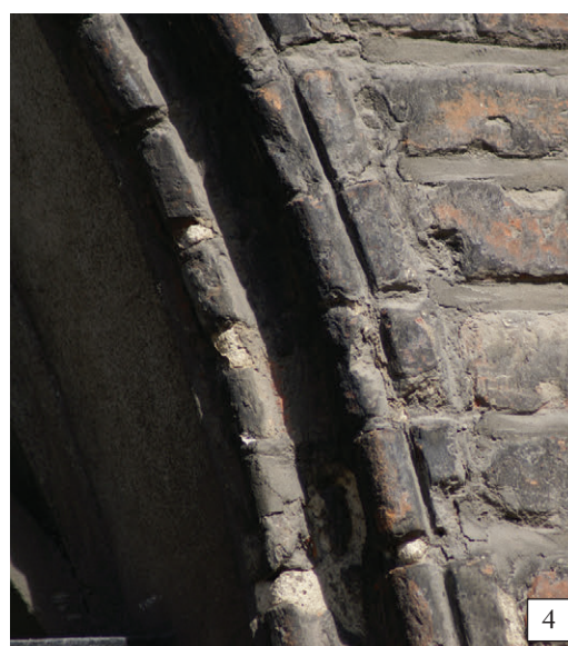
69. Środkowe okno w południowej ścianie zakrystii: 1 – z płytcą i oknami strychu, 2 – ościeża z maswerkiem, 3 – betonowe odlewy wypełnienia łuku, 4 – kształtki ościeża, stan z 2007 r. (fot. E. Łużyńska)
