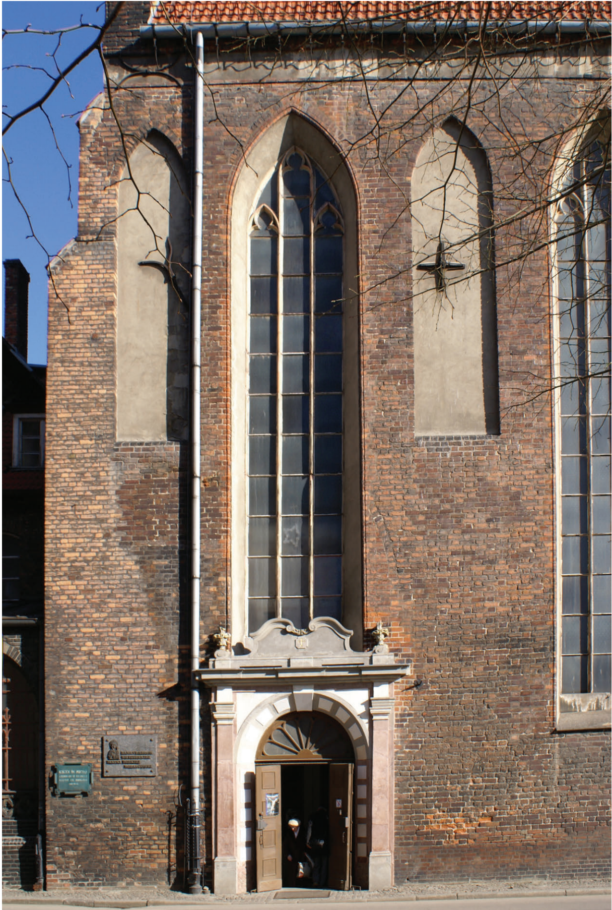
78. Portal zachodni i okno z plicynami w południowej ścianie nawy bocznej, stan z 2007 r. (fot. E. Łużyńska)
