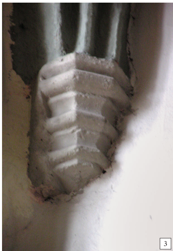
159. Wsporniki o profilach uskokowych w nawach bocznych, stan z 2006 r.:
