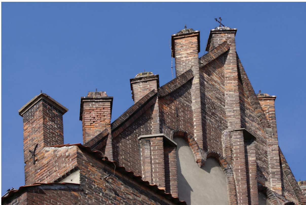
44. Budowa południowej części szczytu wschodniego, stan z 2007 r. (fot. E. Łużyńska)
