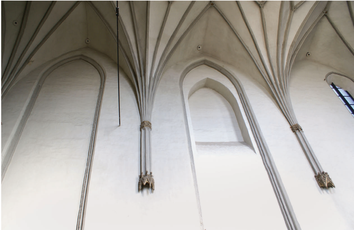
131. Zachodnia część ściany północnej prezbiterium, stan z 2004 r. (fot. E. Łużyniecka)
