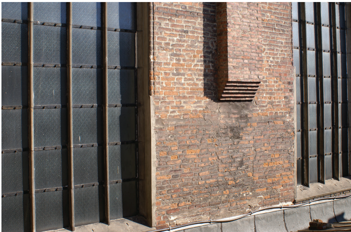
60. Przypora w południowej ścianie prezbiterium widoczna z dachu zakrystii, stan z 2010 r. (fot. E. Łużyniecka)
