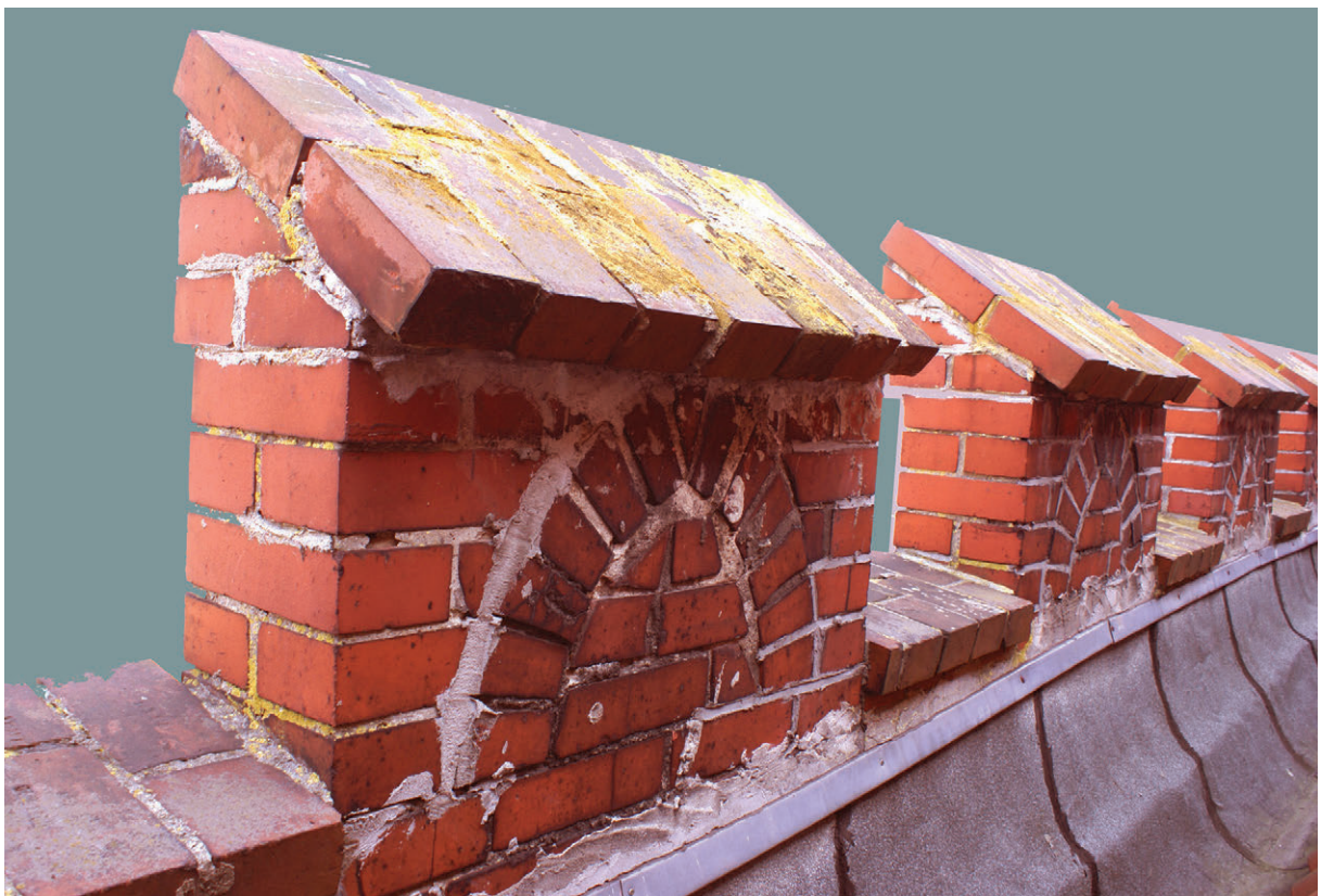
95. Budowa sterzczy attyki widoczna na dachu nawy północnej, stan z 2010 r. (fot. E. Łuzyniecka)
