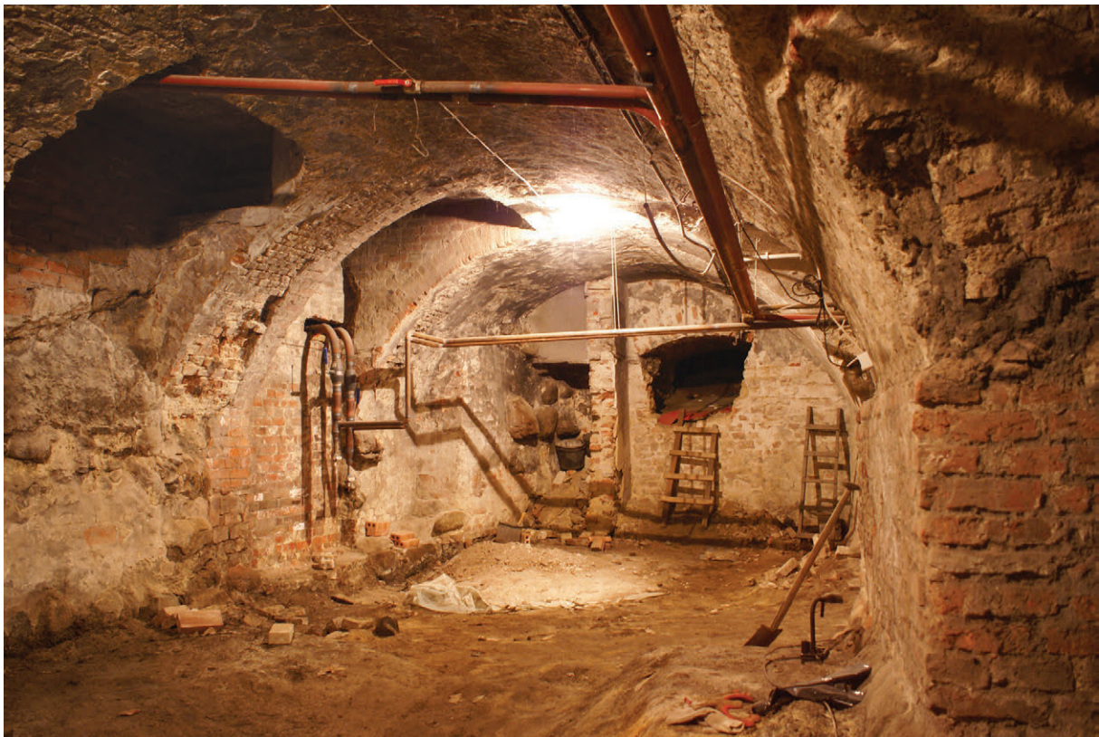
115. Widok części wschodniej wnętrza kotłowni (patrz 104.3), stan z 2004 r. (fot. E. Łużyńska)
