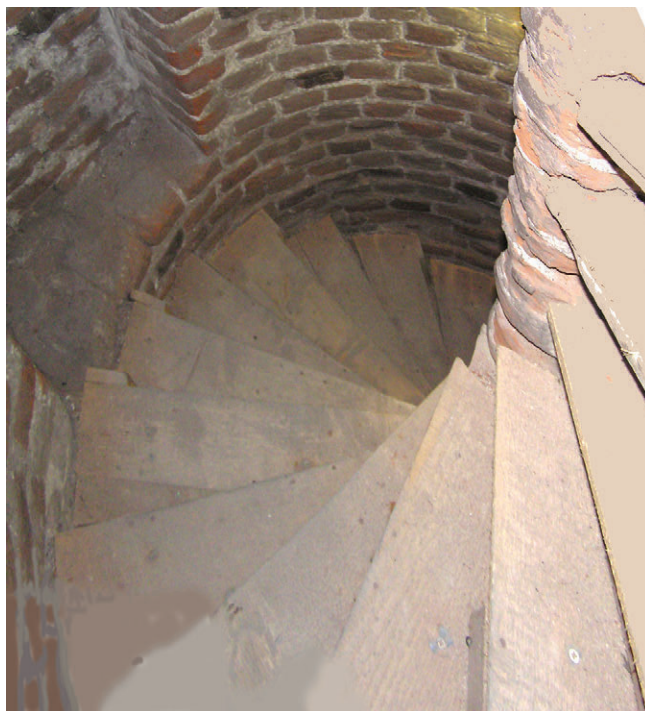
91. Schody w wieżyczce północnej, stan z 2010 r. (fot. E. Łużyńska)
