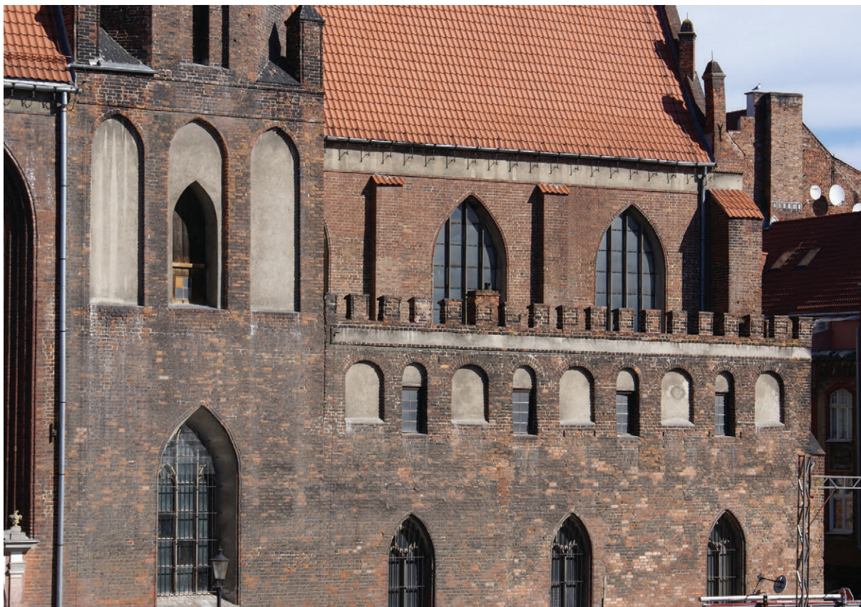
58. Ściany południowe prezbiterium, zakrystii i części wieży, stan z 2010 r. (fot. E. Łuzyniecka)
