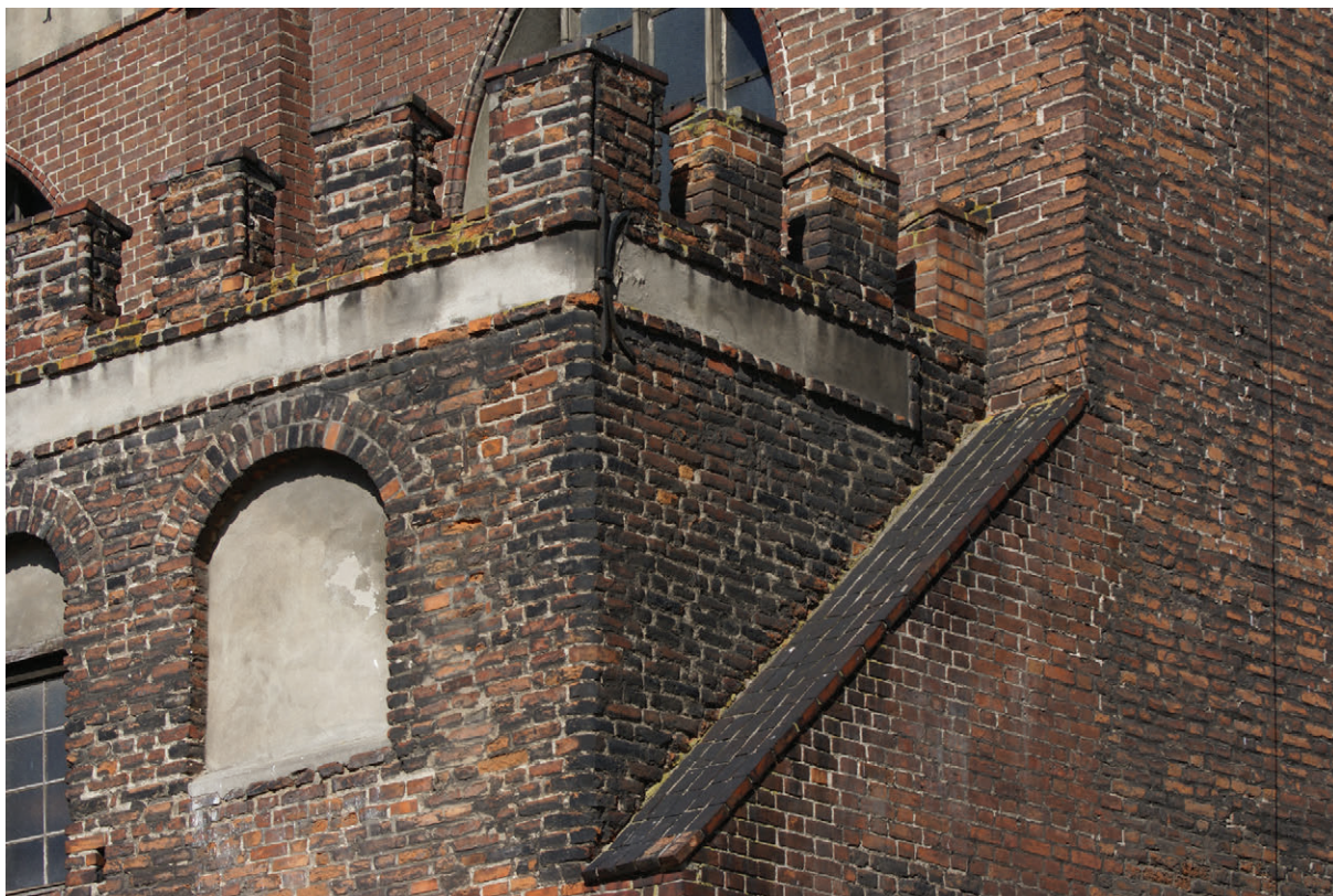
66. Posadowienia attyki na południowo-wschodnim narożniku zakrystii, stan z 2010 r. (fot. E. Łuzyniecka)
