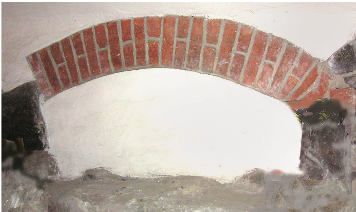
108. Łęk północnego fundamentu prezbiterium widoczny w południowej ścianie kaplicy (patrz 104.1), stan z 2004 r. (fot. E. Łuzyniecka)
