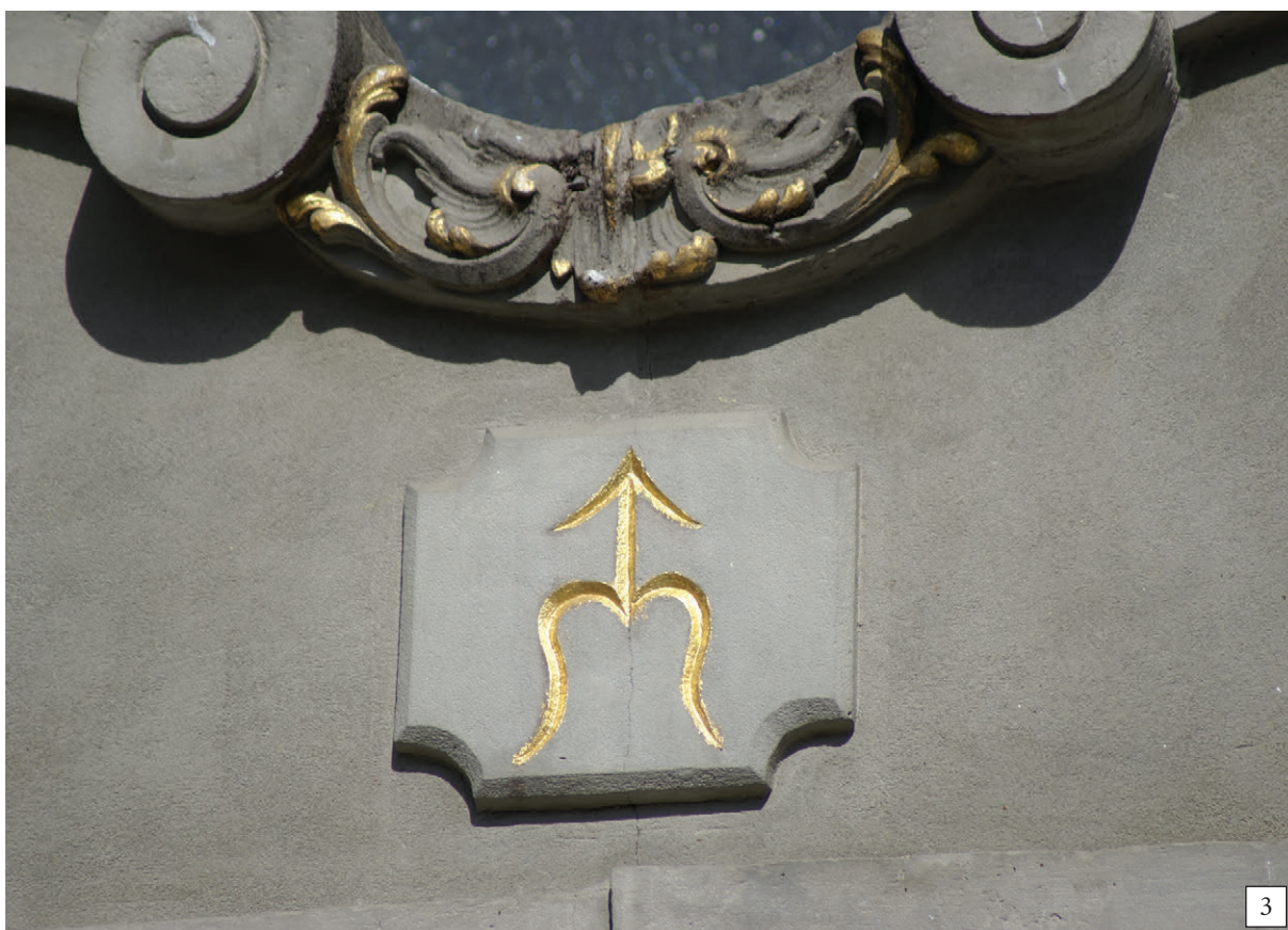
79. Portale w południowej ścianie nawy bocznej: 1 – zachodni, 2 – wschodni, 3 – herb w naczółku, stan z 2007 r. (fot. E. Łużyńska)
