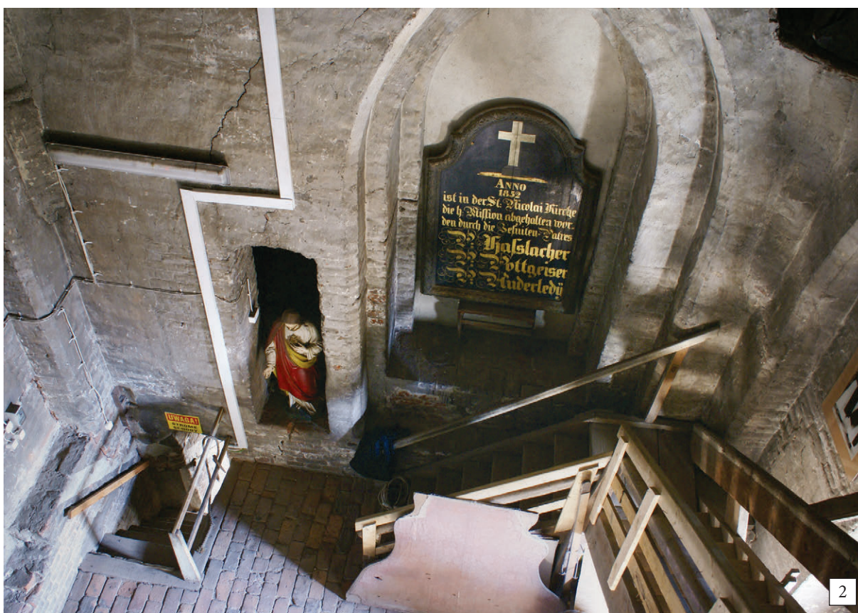
172. Ściana wschodnia drugiej kondygnacji wieży, stan z 2004 r.:
