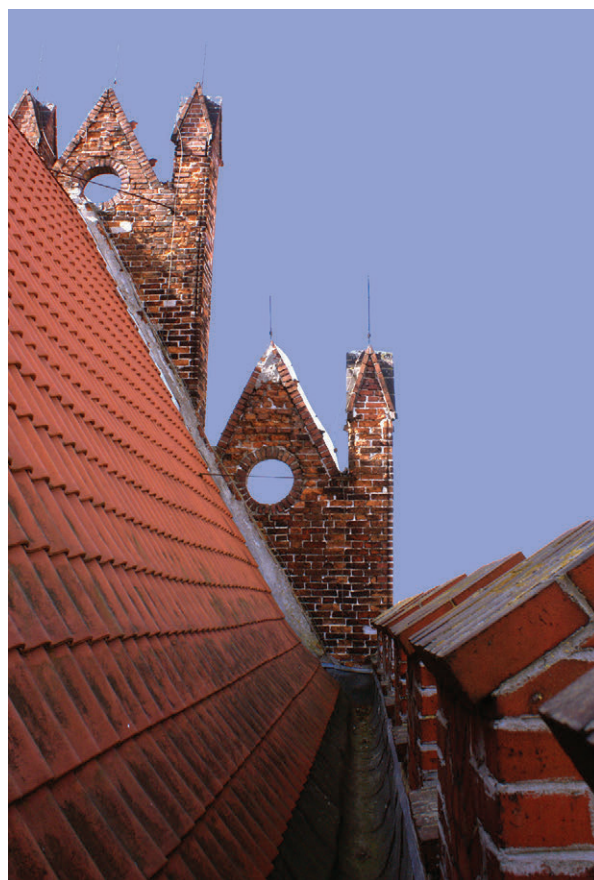
53. Wyjścia i odwodnienia dachów w rejonie szczytu zachodniego, stan z 2010 r. (fot. E. Łużyniecka)
