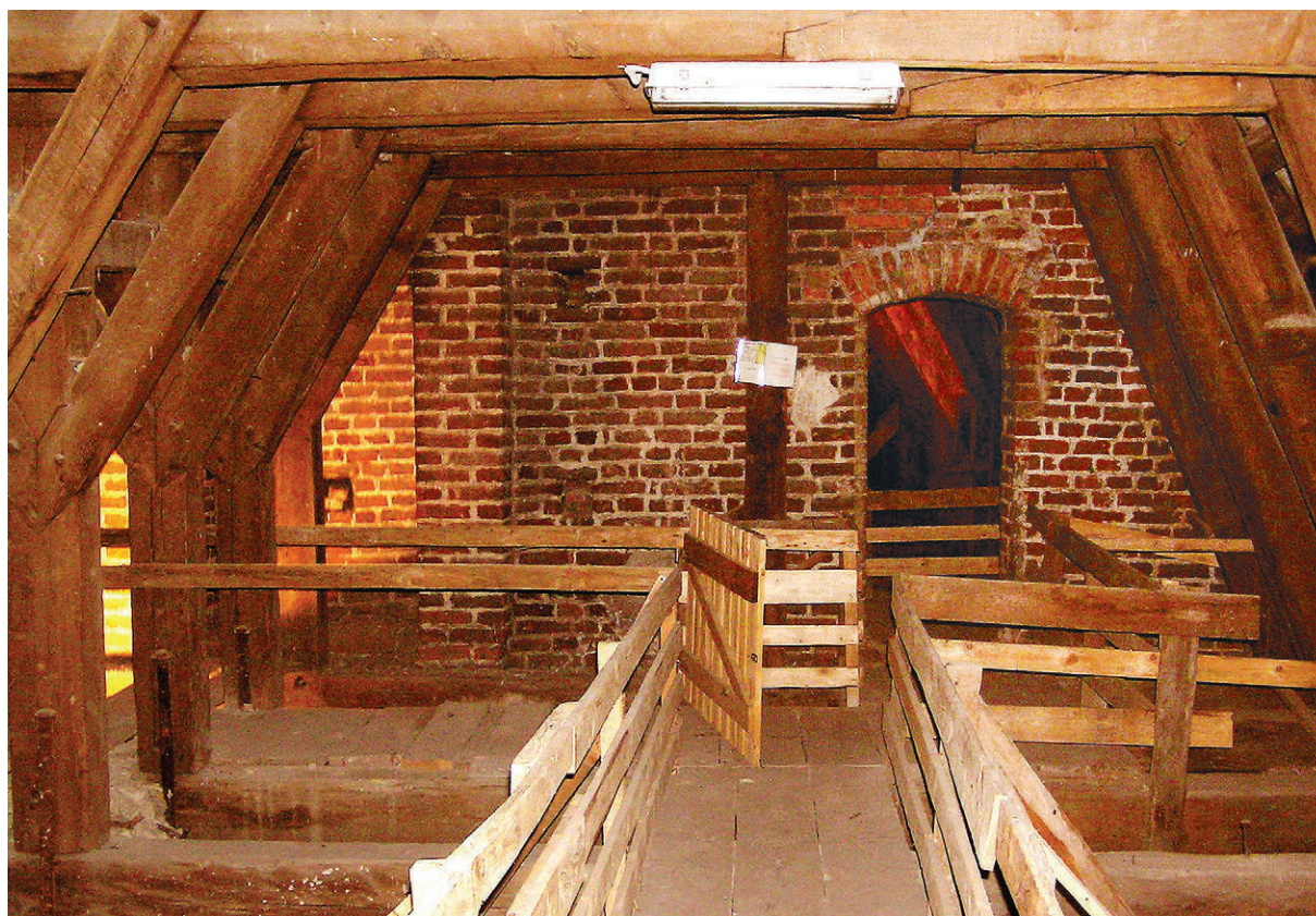
198. Środkowa część ściany między strychem prezbiterium a nawą główną (patrz 196.A), stan z 2007 r. (fot. E. Łużyńska)
