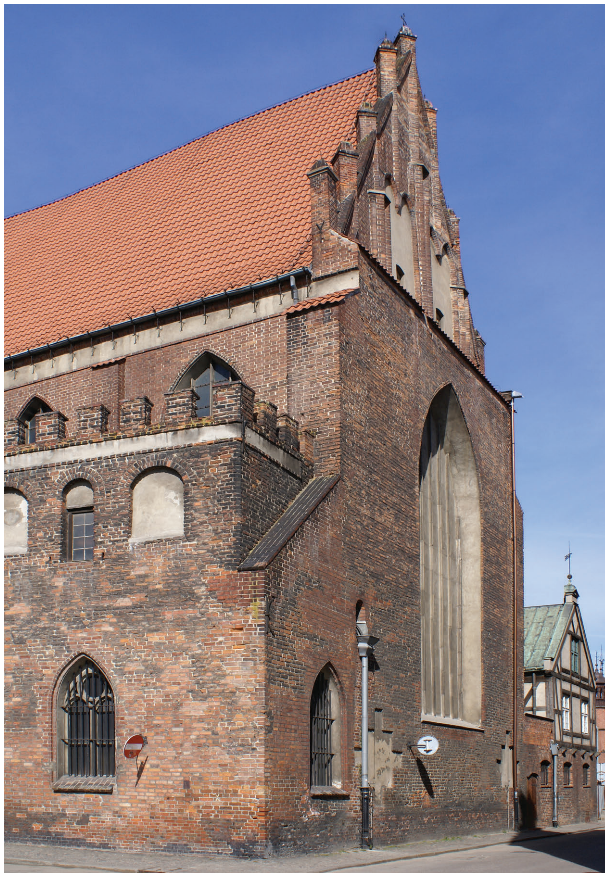
41. Południowo-wschodni narożnik kościoła, stan z 2008 r. (fot. E. Łużyńska)
