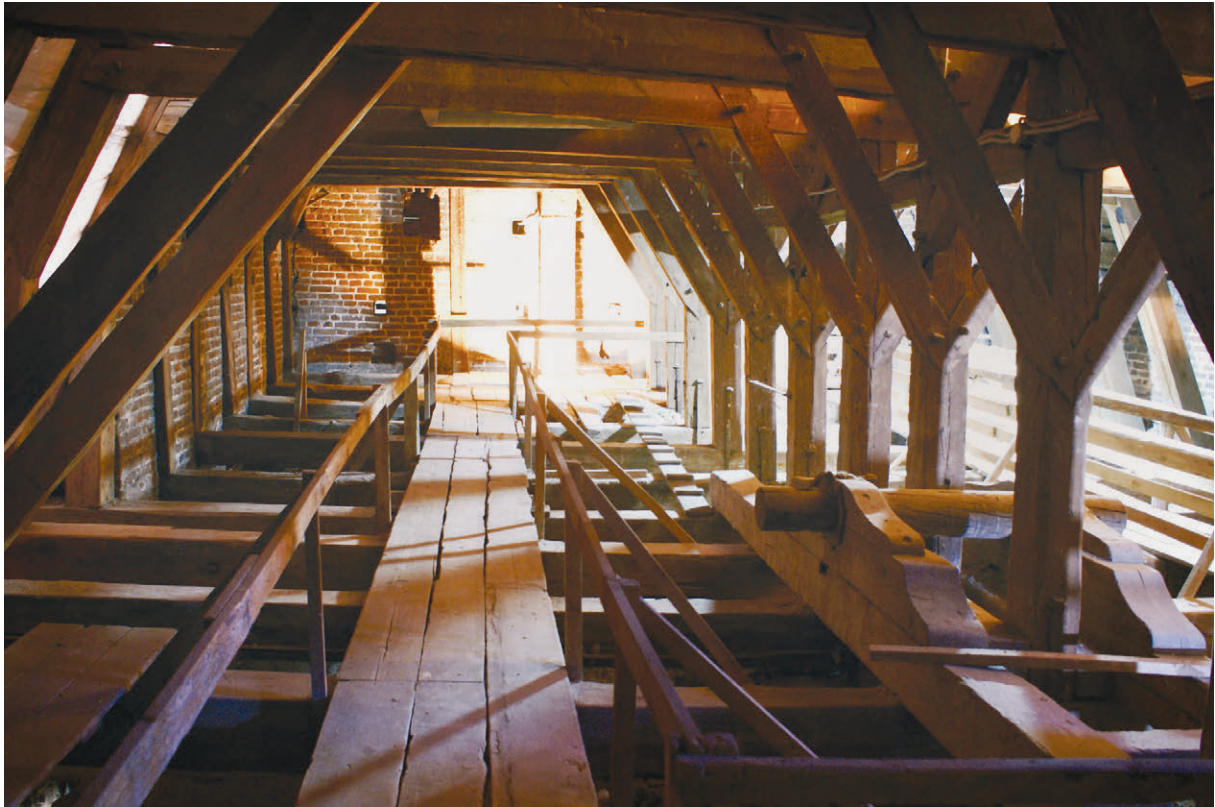
199. Powiązanie dźwigu budowlanego z konstrukcją więźby dachowej prezbiterium (patrz 196.B), stan z 2007 r. (fot. E. Łużyńska)
