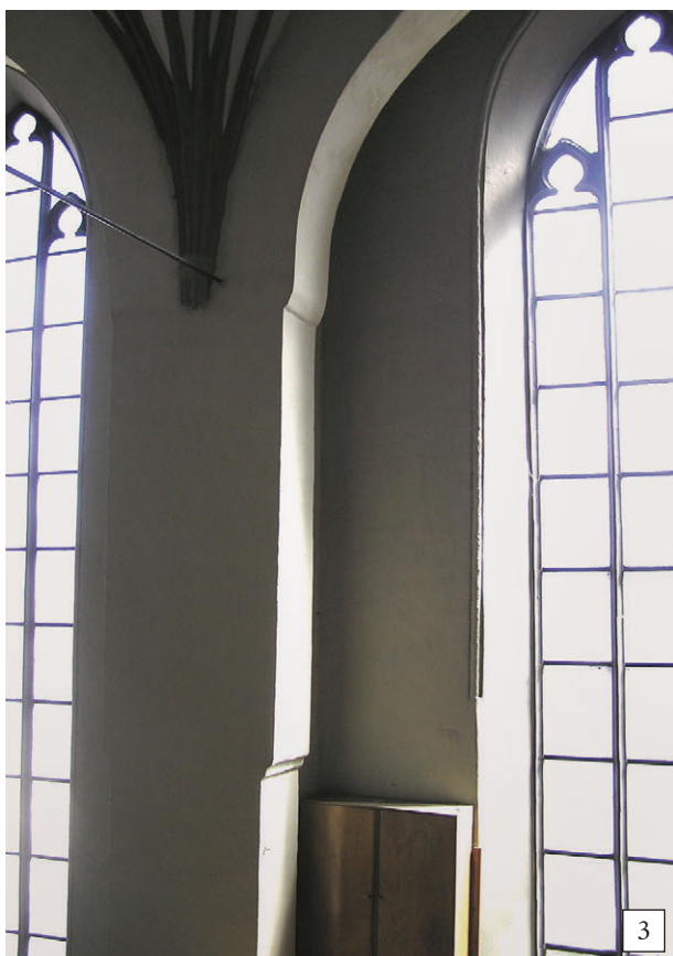
155. Południowa nawa boczna, stan z 2006 r.: 1 – część zachodnia z emporą chórową, 2 – sklepienie, 3, 4 – przypory wewnętrzne (fot. E. Łużyńska)
