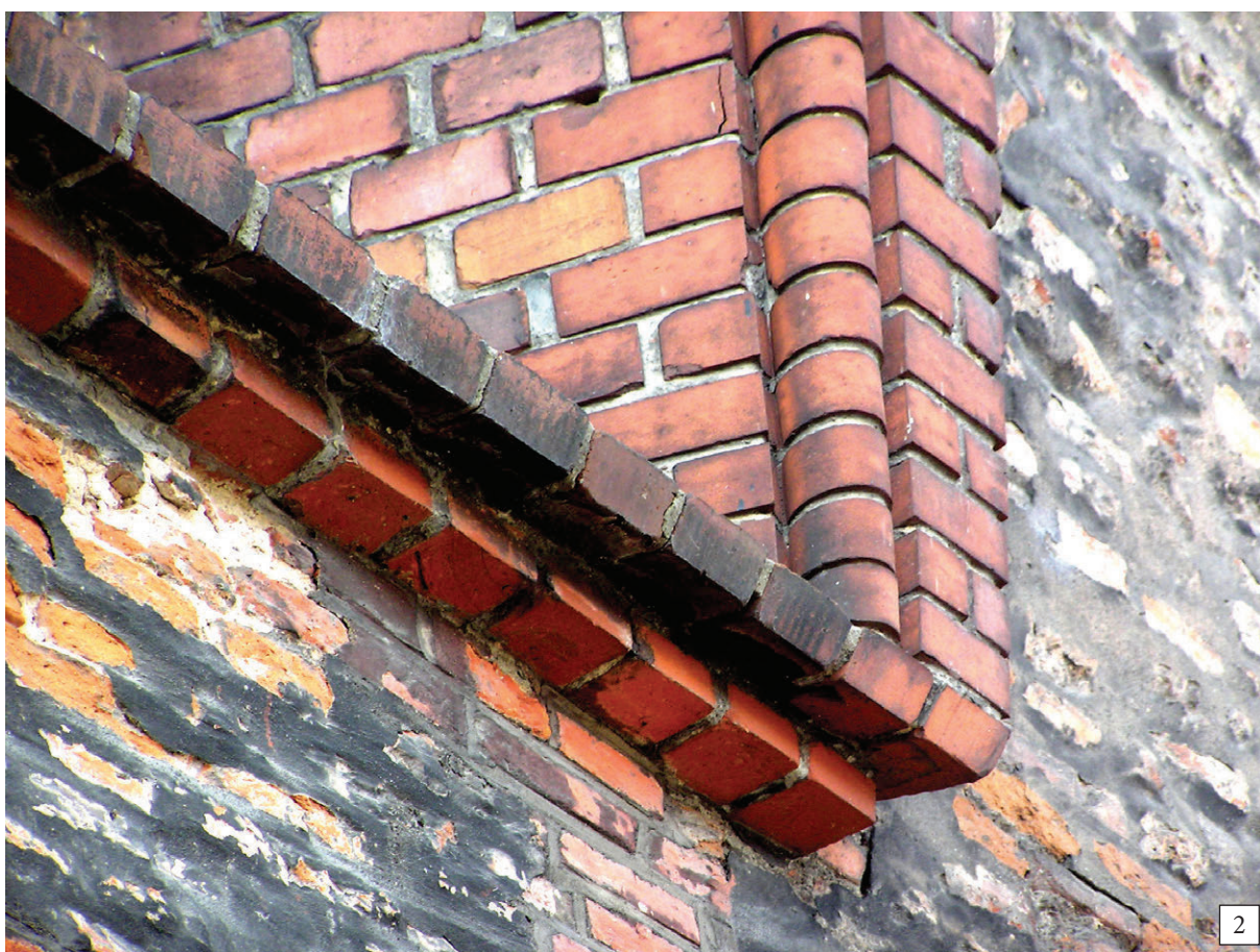
101. Środkowe okno nawy północnej: 1 – ościeże z maswerkiem, 2 – część parapetowa, stan z 2007 r. (fot. E. Łużyńska)
