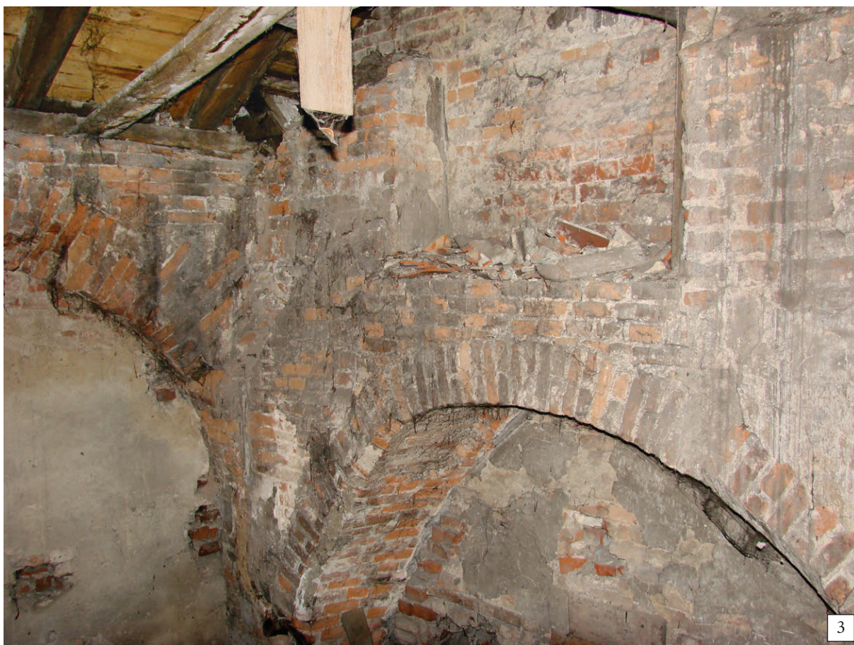
195. Ściana wschodnia strychu nad kaplicą św. Jacka, stan z 2007 r.: 1 – inwentaryzacja budowy (oprac. ZWA PWr), 2 – wejście do wieżyczki północnej, 3 – łęki konstrukcyjne (fot. E. Łużyńska)
