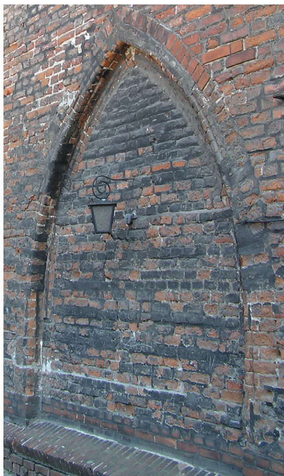
97. Widok zamurowanego łęku, stan z 2007 r. (fot. E. Łużyńska)
