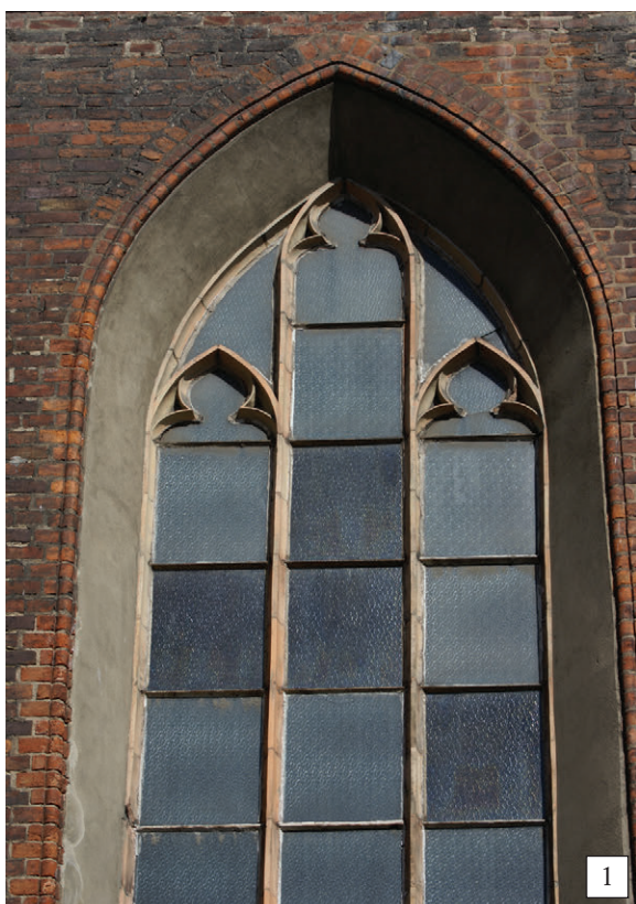
72. Okno w środkowym prześle południowej nawy bocznej: 1 – oścież i maswerk, 2 – betonowy odlew wypełnienia łuku, stan z 2007 r. (fot. E. Łuzyniecka)
