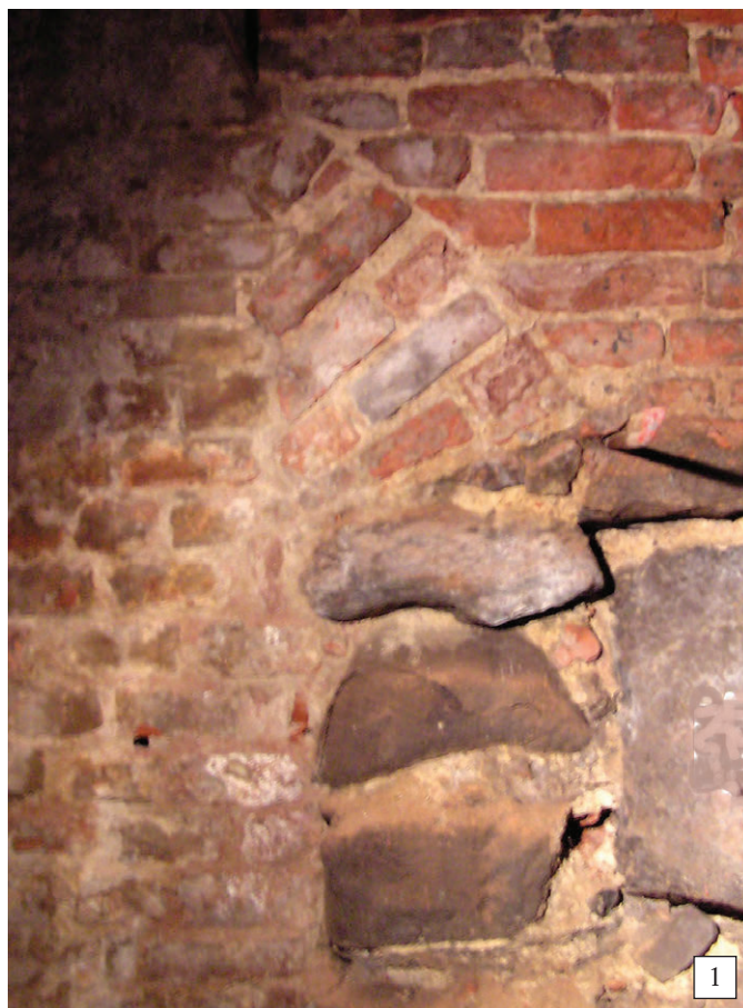
113. Relikt łuku fundamentowego w północnej ścianie łącznika: 1 – widok (fot. E. Łużyniecka), 2 – inwentaryzacja (patrz 104.2), stan z 2004 r. (oprac. ZWA PWr)
