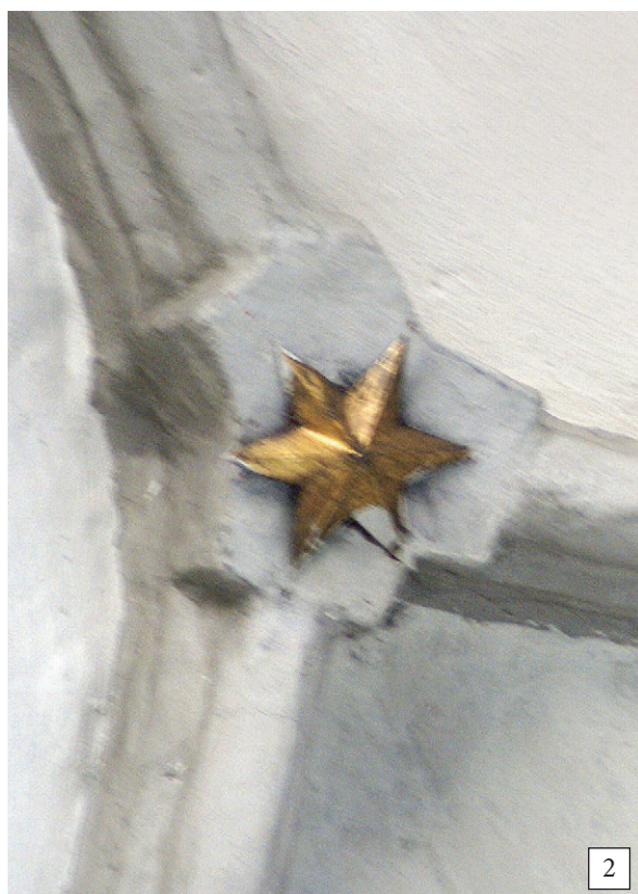
136. Sklepienia gwiazdziste prezbiterium, stan z 2007 r.: 1 – przeszła środkowe, 2 – zwornik boczny, 3 – połączenie żeber w kluczu (fot. E. Łuzyniecka)
