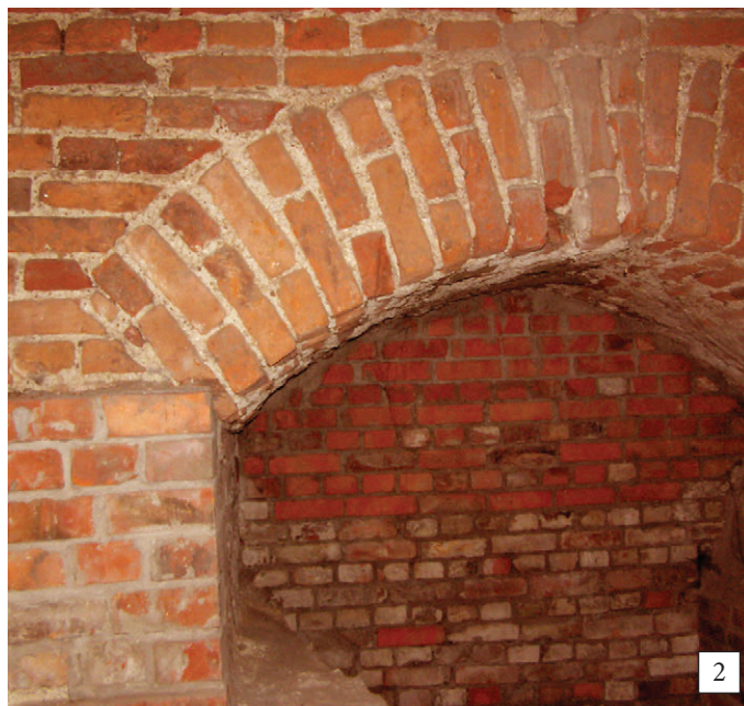
112. Łęk fundamentowy w południowej ścianie łącznika: 1 – inwentaryzacja (oprac. ZWA PWr), 2 – widok (patrz 104.2), stan z 2004 r. (fot. E. Łużyniecka)
