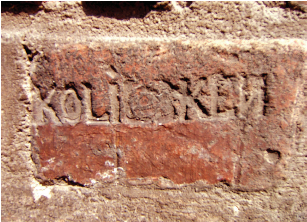
103. Cegła w części cokołowej ściany nawy północnej, stan z 2007 r. (fot. E. Łuzyniecka)
