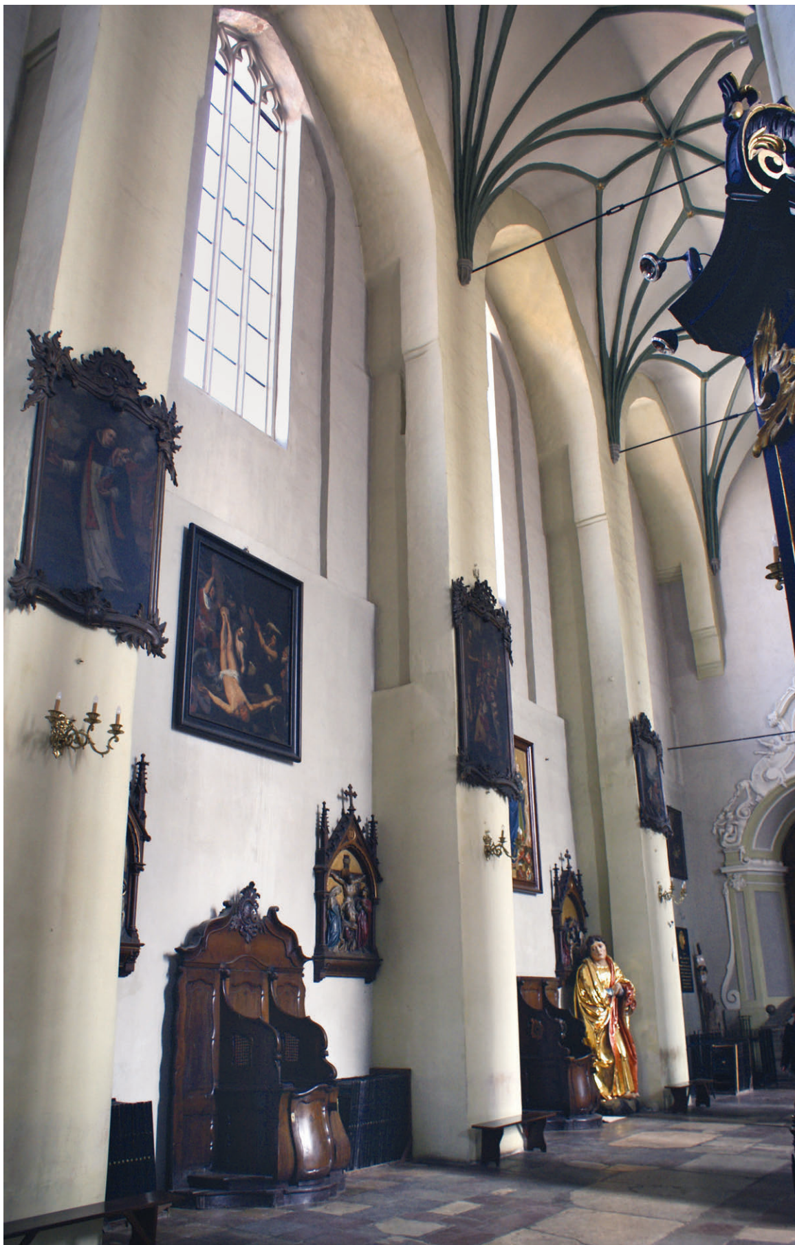
156. Północna nawa boczna, sklepienie i przypory wewnętrzne, stan z 2006 r. (fot. E. Łużyniecka)
