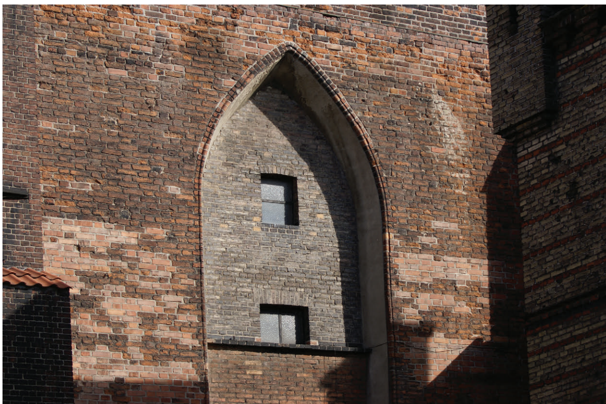
49. Okno w zachodniej ścianie nawy głównej, stan z 2010 r. (fot. E. Łuzyniecka)
