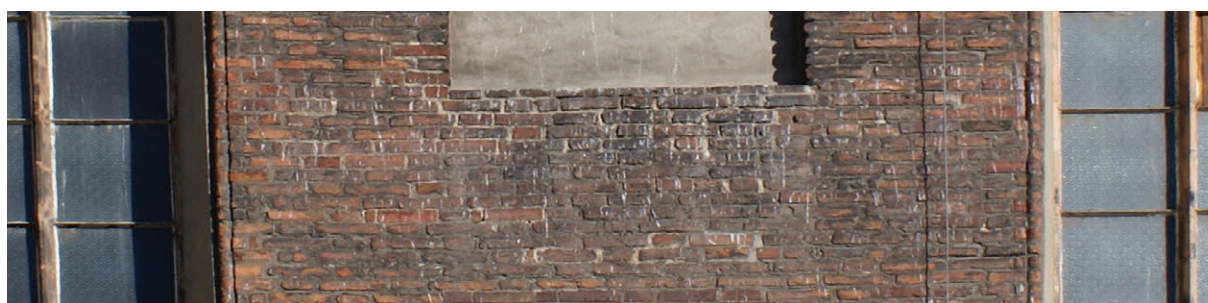
74. Cegły i kształtki ceramiczne w dolnej części płyciny i ościeżach okien, stan z 2007 r. (fot. E. Łużyńska)
