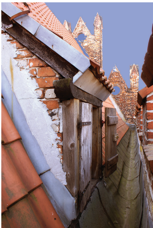
53. Wyjścia i odwodnienia dachów w rejonie szczytu zachodniego, stan z 2010 r. (fot. E. Łużyniecka)
