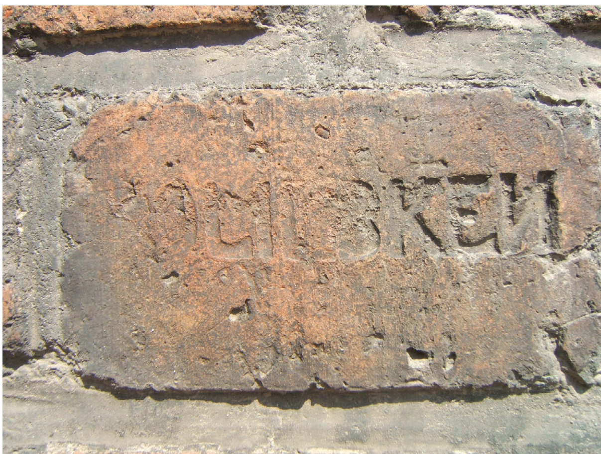
81. Sygnatury i napisy producentów umieszczone na ceglach w części cokołowej ściany południowej nawy bocznej, stan z 2007 r. (fot. E. Łużyniecka)
