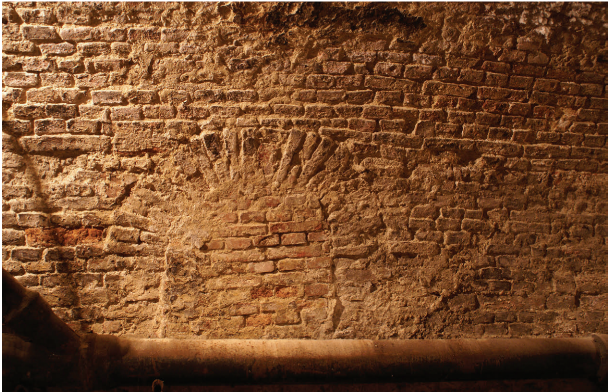
119. Zamurowany otwór w północnej powłoce sklepienia kotłowni (patrz 104.3), stan z 2004 r. (fot. E. Łużyńska)
