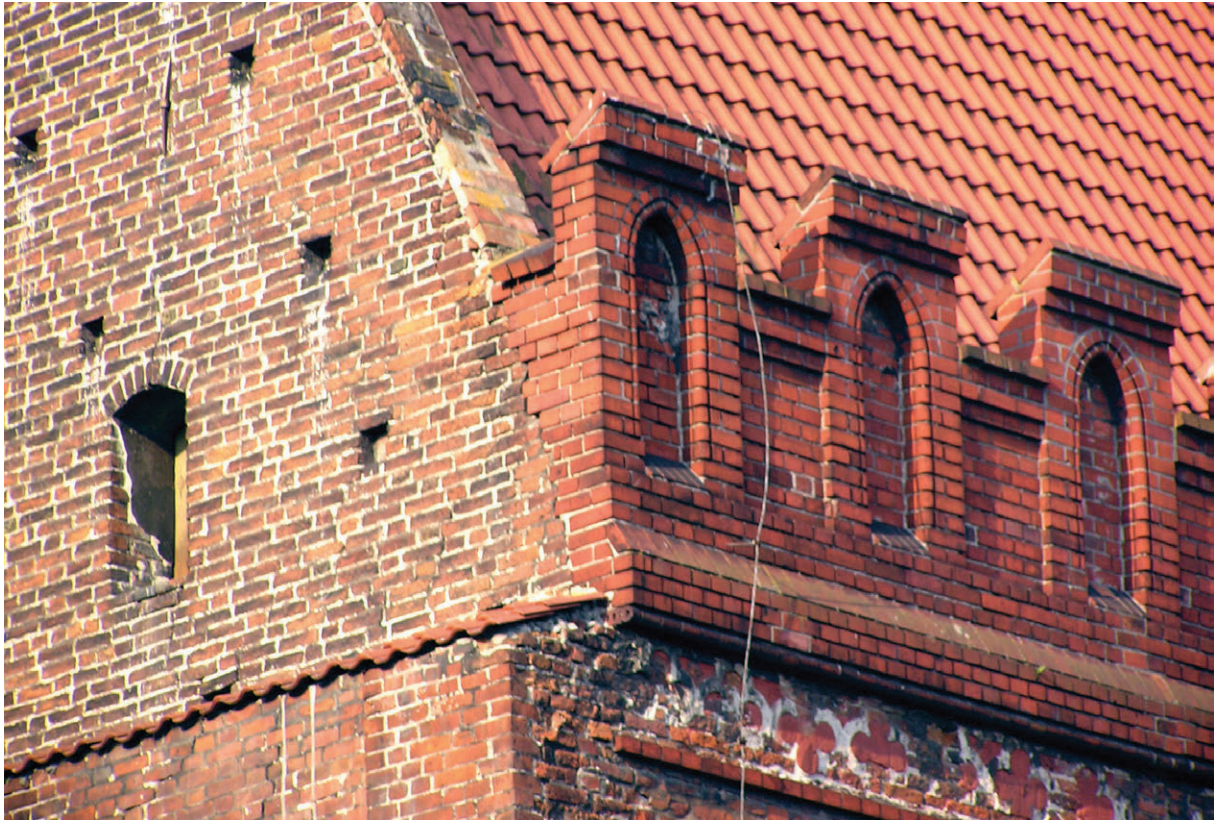
94. Wschodni szczyt północnej nawy bocznej i dostawiona do niego attyka, stan z 2010 r. (fot. E. Łuzyniecka)
