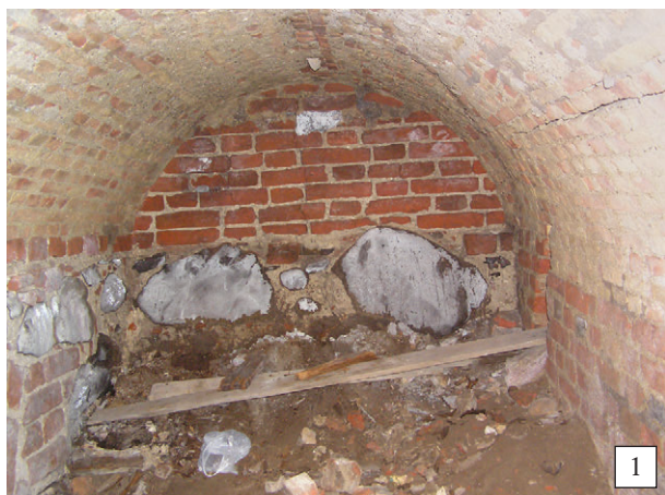
123. Fragment fundamentu i części nadziemnej wschodniej ściany prezbiterium we wnętrzu kanału (patrz 104.4): 1 – widok (fot. E. Łużyniecka), 2 – inwentaryzacja (oprac. ZWA PWŕ)
