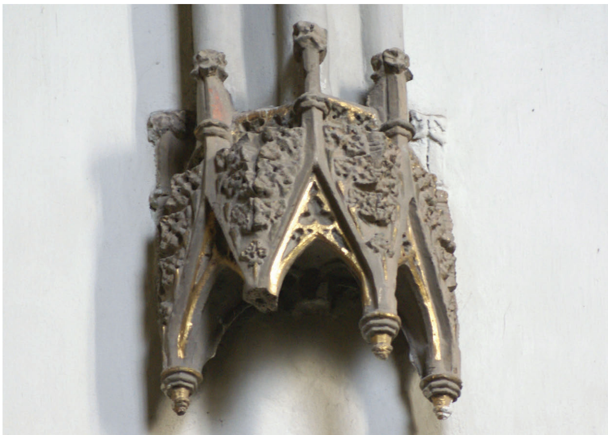
140. Baldachiny wspornikowe wiązek słupek w ścianie południowej, stan z 2007 r. (fot. E. Łużyniecka)
