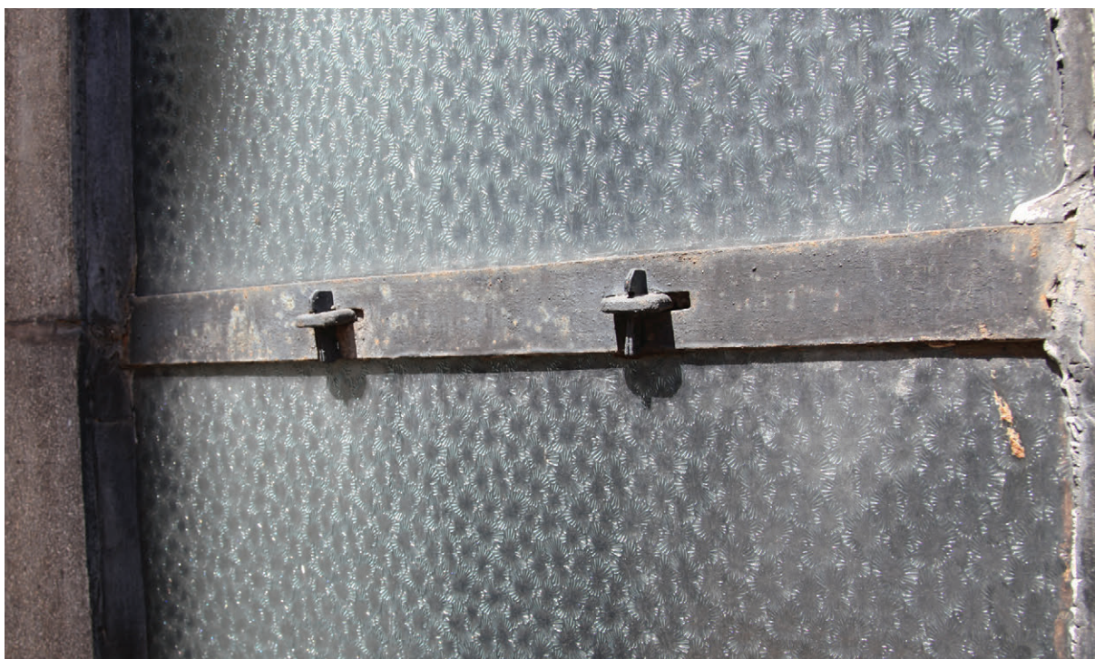
65. Konstrukcja łączenia tafli szklanych w oknie prezbiterium, stan z 2010 r. (fot. E. Łużyńska)
