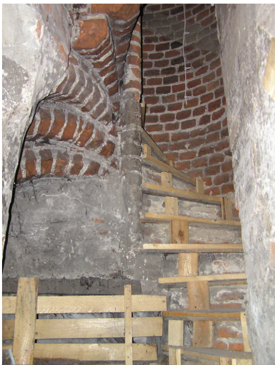
90. Połączenie strychu nad kaplicą św. Jacka ze strychem prezbiterium, stan z 2010 r. (fot. E. Łużyńska)
