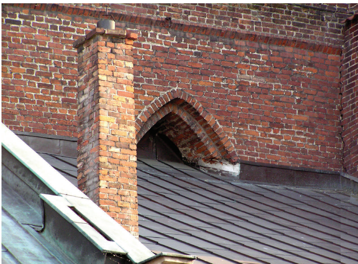
87. Łęk zachodniego okna w północnej ścianie prezbiterium i dostawiony do niej mur wschodni nawy północnej, stan z 2010 r. (fot. E. Łuzyniecka)
