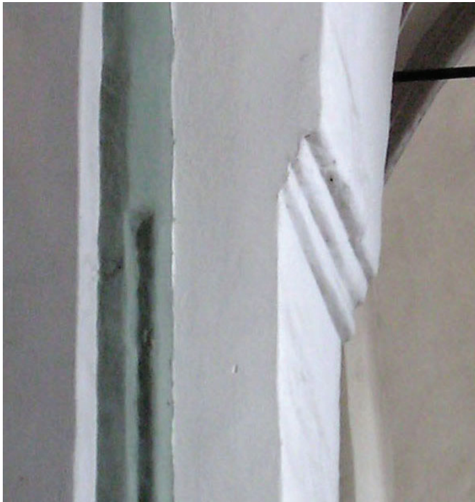
132. Wyprowadzenie północnej części łuku tęczowego, stan z 2004 r. (fot. E. Łużyniecka)
