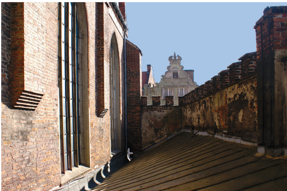
67. Dach zakrystii z attyką i ścianą południową prezbiterium, stan z 2010 r. (fot. E. Łuzyniecka)
