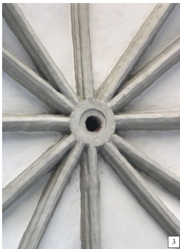
136. Sklepienia gwiazdziste prezbiterium, stan z 2007 r.: 1 – przeszła środkowe, 2 – zwornik boczny, 3 – połączenie żeber w kluczu (fot. E. Łuzyniecka)
