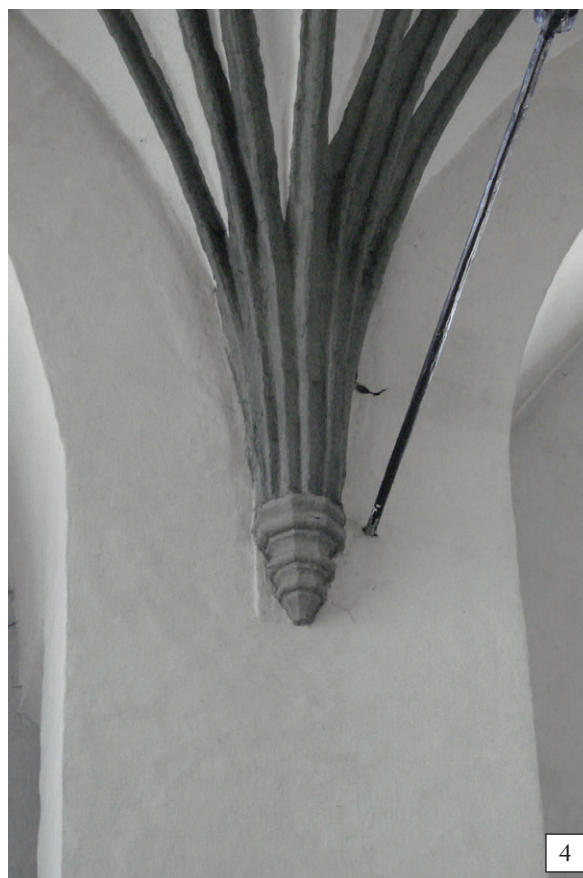
157. Wyprowadzenia żeber, stan 2006 r.: 1 – nawa południowa, 2, 3 – nawa główna, 4 – nawa północna (fot. E. Łużyńska)
