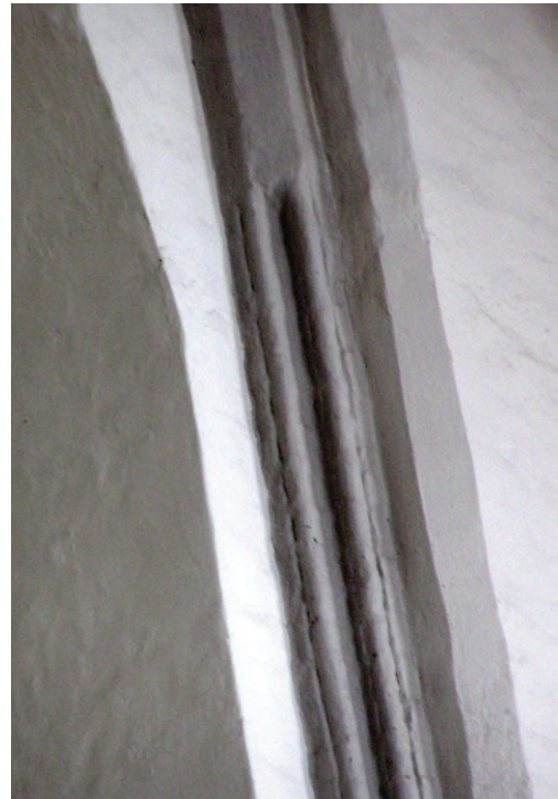
133. Profilowanie wschodniego fragmentu ościeży okna w zachodniej części ściany północnej, stan z 2004 r. (fot. E. Łużyniecka)
