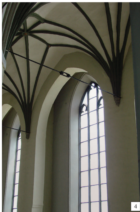
155. Południowa nawa boczna, stan z 2006 r.: 1 – część zachodnia z emporą chórową, 2 – sklepienie, 3, 4 – przypory wewnętrzne (fot. E. Łużyńska)
