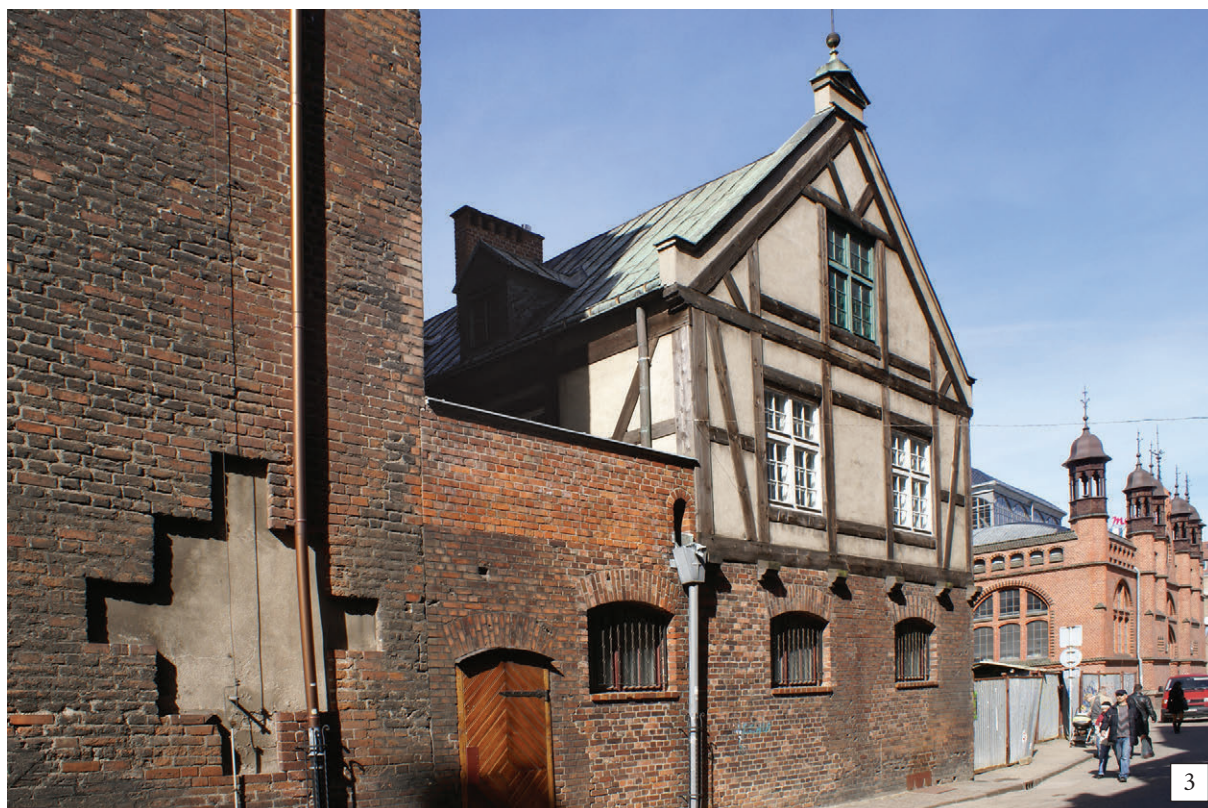
40. Wschodnia elewacja kościoła z tzw. Górką Dominikańską, stan z 2004 r.: 1 – aktualizacja inwentaryzacji według [ACD, 1, 7] (oprac. ZWA PWr), 2 – widok od północnego wschodu, 3 – ujęcie od południowego wschodu (fot. E. Łużyńska)
