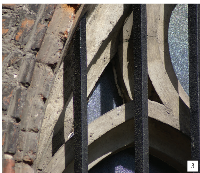
69. Środkowe okno w południowej ścianie zakrystii: 1 – z płytcą i oknami strychu, 2 – ościeża z maswerkiem, 3 – betonowe odlewy wypełnienia łuku, 4 – kształtki ościeża, stan z 2007 r. (fot. E. Łużyńska)
