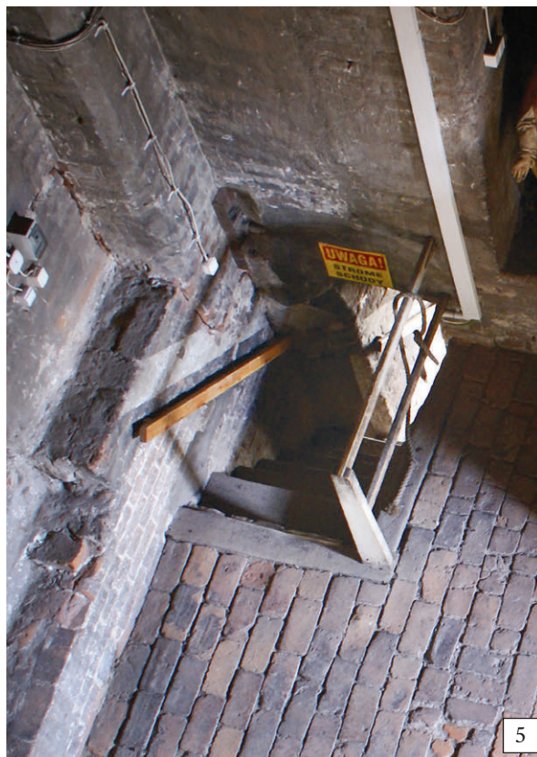
170. Druga kondygnacja wieży, stan z 2004 r.: 1 – ściana północna, 2 – rzut (oprac. ZWA PWr), 3 – ściana południowa, 4, 5 – schody we wnętrzu muru (fot. E. Łużyniecka)
