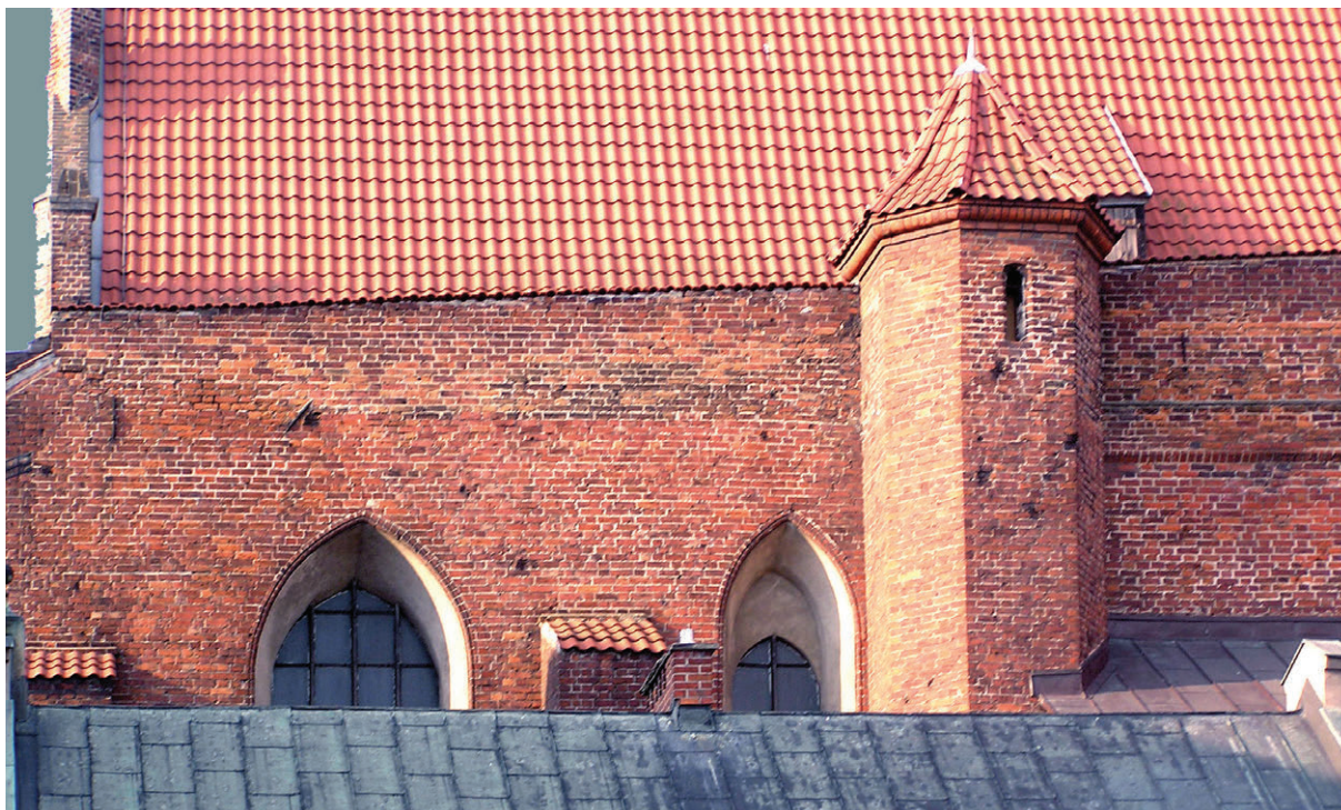
86. Górna część wschodniego fragmentu północnej ściany prezbiterium, stan z 2010 r. (fot. E. Łuzyniecka)
