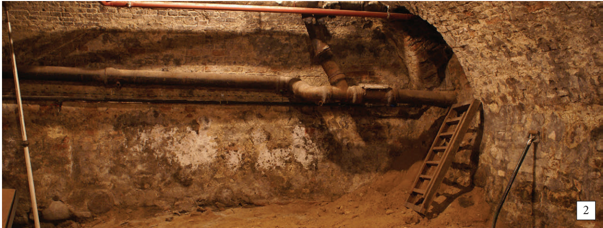
118. Ściana północna kotłowni: 1 – inwentaryzacja (oprac. ZWA PWr), 2 – widok części wschodniej (patrz 104.3), stan z 2004 r. (fot. E. Łużyńska)
