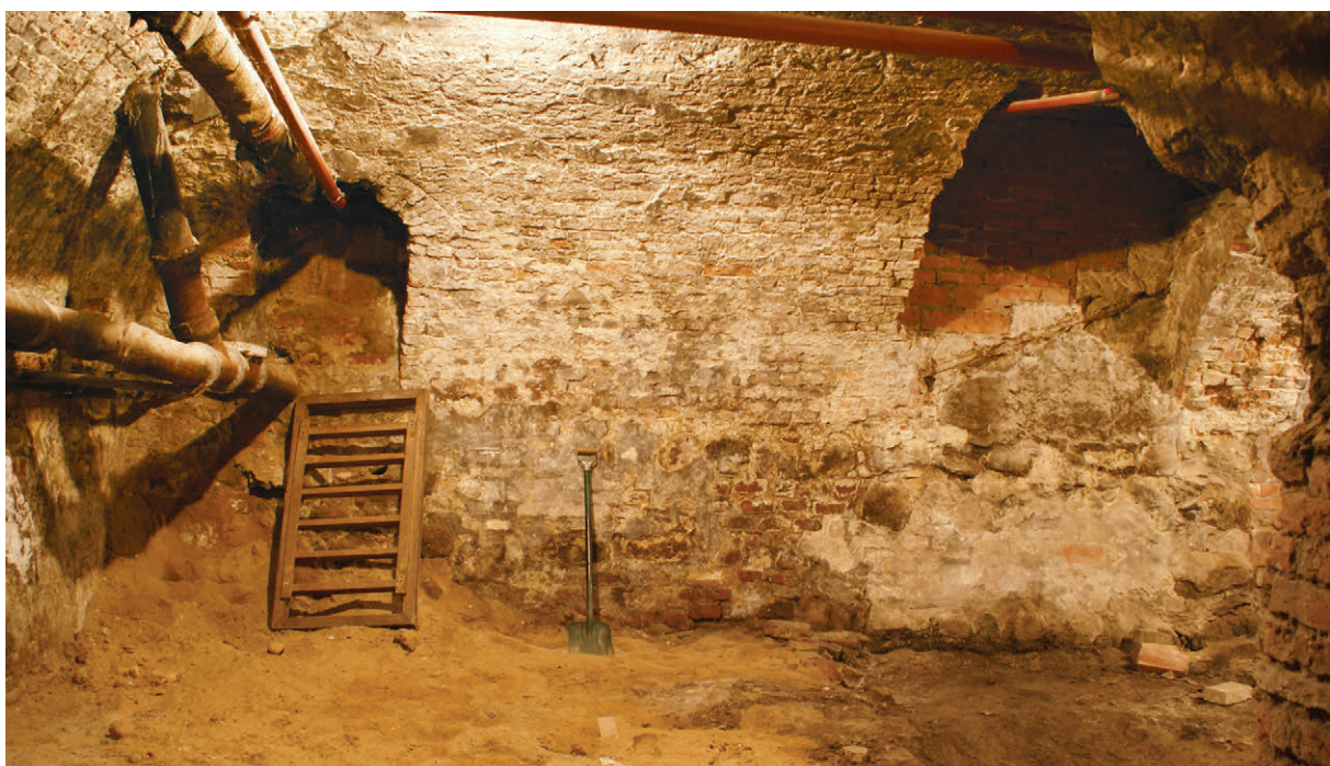
121. Widok północnej części ściany wschodniej kotłowni (patrz 104.3), stan z 2004 r. (fot. E. Łużyńska)
