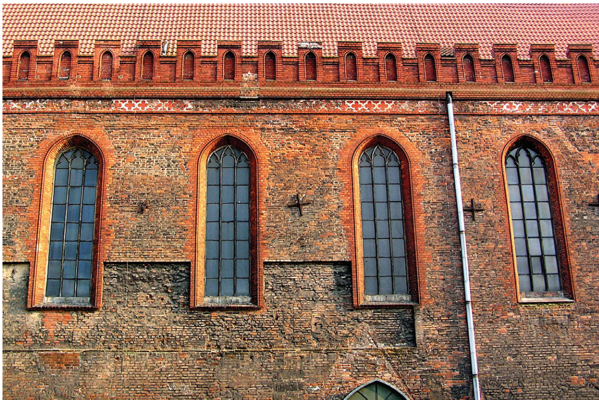
92. Górna część ściany północnej nawy bocznej ze śladami oparcia dachu krużganka, stan z 2010 r. (fot. E. Łużyńska)
