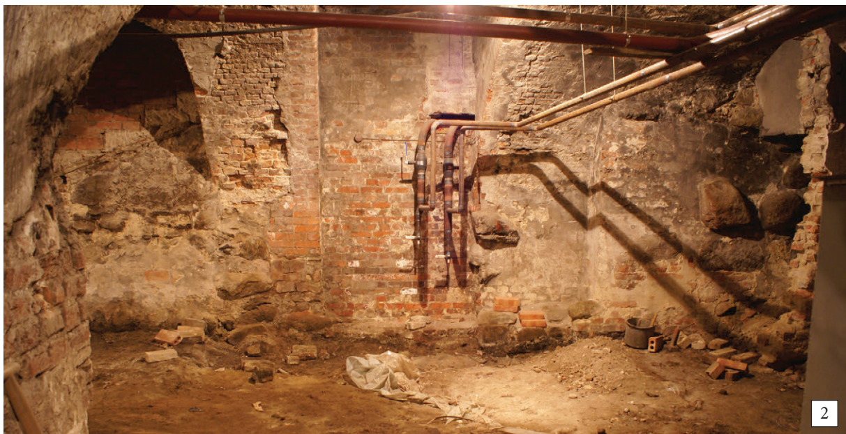
120. Ściana wschodnia kotłowni:
