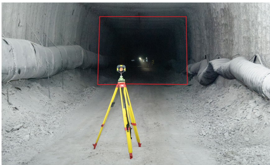
Rysunek 1. Wygląd typowego wyrobiska wykonanego w soli kamiennej kombajnem chodnikowym. Czerwonym prostokątem zaznaczono uproszczony przekrój poprzeczny wyrobiska (prostokąt zaznaczony na fotografii ma wymiary 5,3 m na 8,1 m). Na zdjęciu można zauważyć także dużą gładkość powierzchni ociosów, stropu i spągu wyrobiska, co jest charakterystyczną cechą tych wyrobisk. Taki kształt powierzchni ociosów, stropu i spągu chodników znacząco wpływa na zmniejszenie oporu przepływu powietrza.
