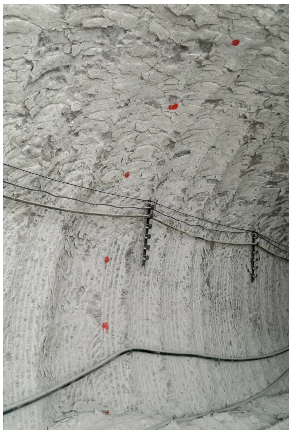
Rysunek 7. Przykładowe rozmieszczenie punktów pomiarowych przekroju poprzecznego wyrobiska. Punkty zostały namalowane czerwoną farbą emulsyjną, co zapewniło maksymalną możliwą widoczność każdego z nich.
