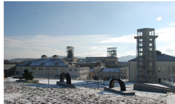
Il. 28.1. Widok na dawną Kopalnię Julia
