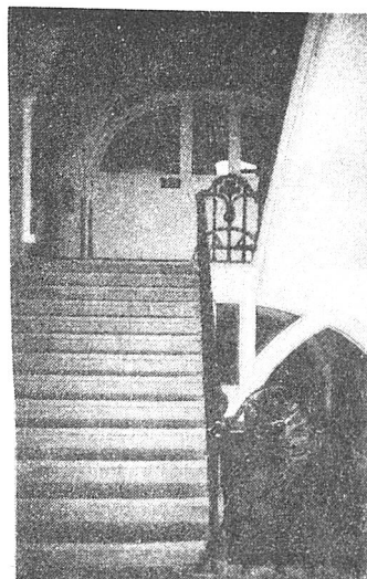
Rys. 7.32. Schody dwubiegowe prawoskrętne. Fot. autorki Fig. 7.32. Right turn bi-flight stairs. Photo:author
