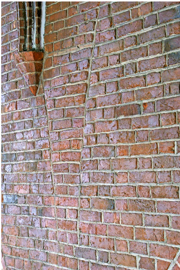
Il. 74. Kościół św. Mikołaja – ściana południowa nawy głównej (2014): 1 – widok od strony nawy głównej, 2 – ślad po wcześniejszym sklepieniu, 3 – wspornik obecnego sklepienia po stronie zachodniej; fot. E.Ł.
