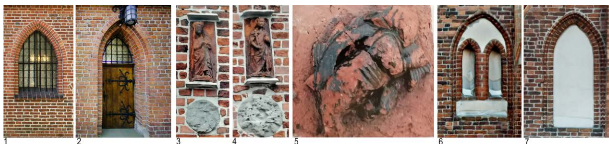
Il. 17. Detale elewacji kościoła św. Mikołaja (stan z 2023): 1, 2 – ściana północna zakrystii AJS 7, 3–5 – zachodnia ściana trzeciego piętra wieży AJS 7, 6, 7 – zachodni szczyt nawy północnej AJS 8; fot. F.H., E.Ł.
