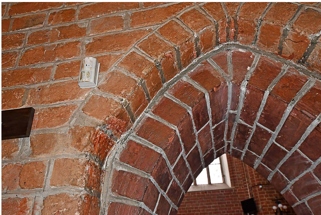
Il. 87. Kościół św. Mikołaja – wnętrze zakrystii (2023): 1 – przekrój H-H, 2 – wejście do prezbiterium, 3 – uskokowy profil portalu od strony zakrystii z widoczną różnicą w użytym materiale; fot. i oprac. F.H.
