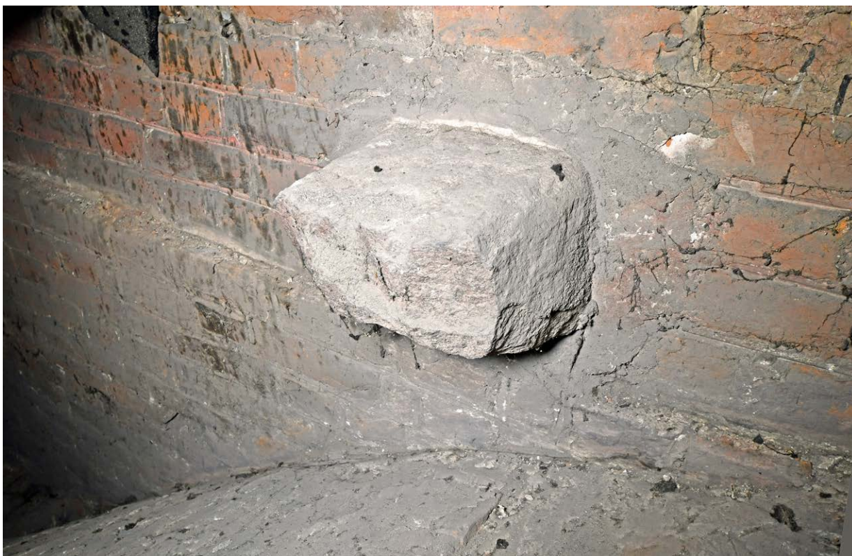
Il. 103. Kościół św. Mikołaja – strych nad nawą północną, kamienna konsola więzby dachowej w ścianie arkadowej (2023); fot. F.H.
