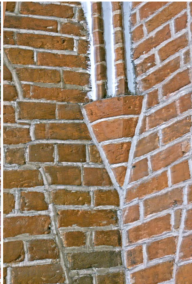
Il. 74. Kościół św. Mikołaja – ściana południowa nawy głównej (2014): 1 – widok od strony nawy głównej, 2 – ślad po wcześniejszym sklepieniu, 3 – wspornik obecnego sklepienia po stronie zachodniej; fot. E.Ł.
