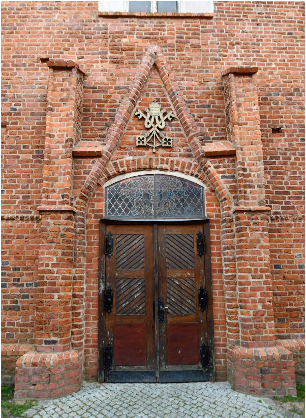
Il. 60. Kościół św. Mikołaja, elewacja zachodnia – portal główny (2023); fot. F.H.
