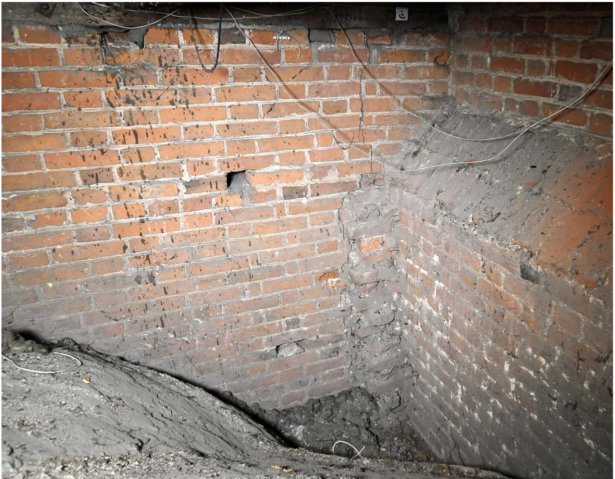
Il. 99. Kościół św. Mikołaja – strych nad nawą główną (2023): 1 – ściana południowa nad sklepieniem, fotogrametryczny, oteksturowany model siatkowy, ortofotografia, 2 – pacha sklepienna; oprac. i fot. F.H.
