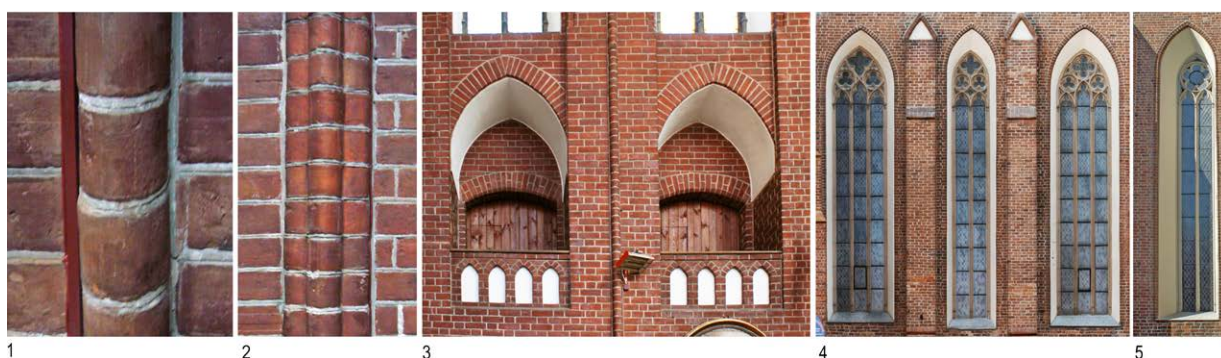
Il. 20. Elementy prezbiterium AJS 11 (stan z 2023): 1, 2 – służki, 3 – empora nad zakrystią, 4, 5 – maswerki; fot. F.H., E.Ł.
