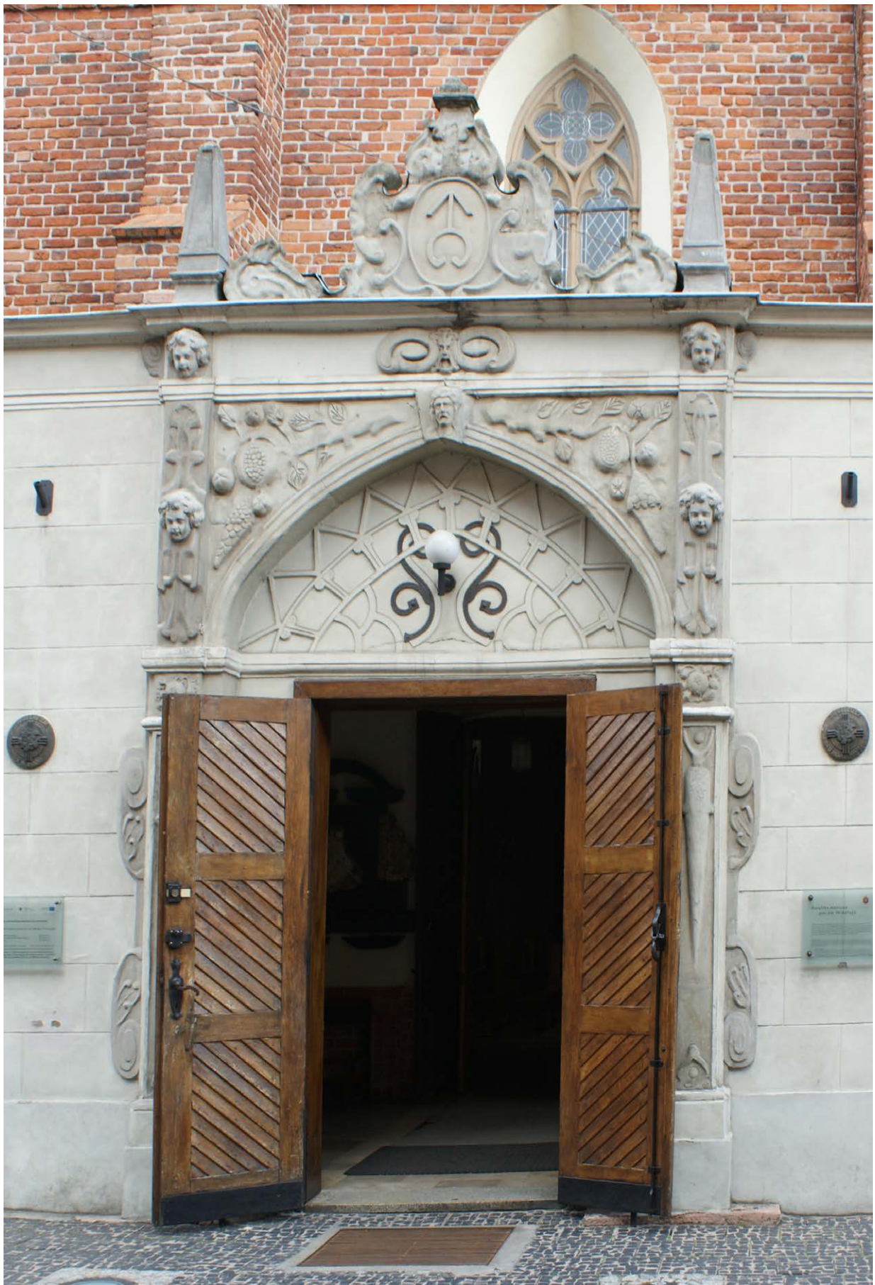
Il. 42. Kościół św. Mikołaja – portal wejściowy do kruchty południowej (2014); fot. E.Ł.
