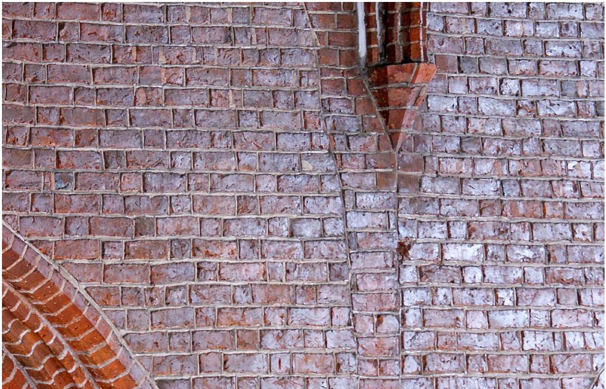
Il. 75. Kościół św. Mikołaja – ściana północna nawy głównej (2014): 1 – widok z empyry zachodniej, 2 – wspornik obecnego sklepienia i ślad po wcześniejszym; fot. E.Ł.
