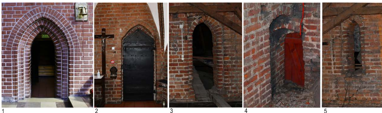
Il. 7. Obudowa otworów w AJS 1 (stan z 2023) – przejścia: 1, 2 – z prezbiterium do zakrystii, 3 – ze strychu nad prezbiterium do części nawowej, 4 – z wieżyczki na strych prezbiterium; 5 – otwór w ścianie szczytowej prezbiterium; fot. F.H., E.Ł.
