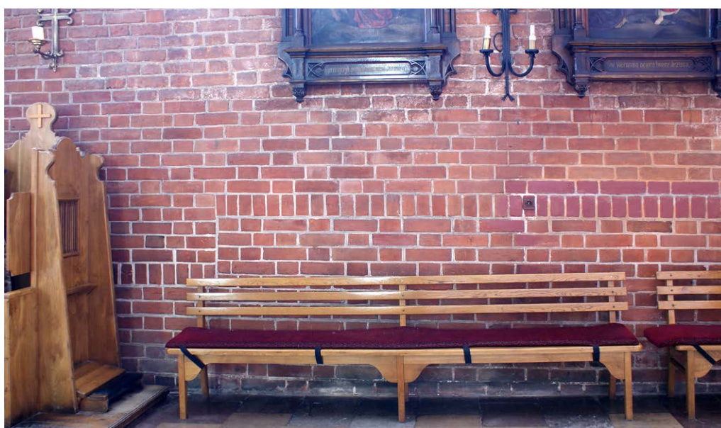
Il. 81. Kościół św. Mikołaja – ściana południowa nawy południowej: 1 – przekrój D-D (2023), oprac. F.H., 2 – część zachodnia (2014), fot. E.Ł., 3 – fragment środkowy z widocznymi rollkami cegieł na sztorc na dwóch poziomach (2014), fot. E.Ł.
