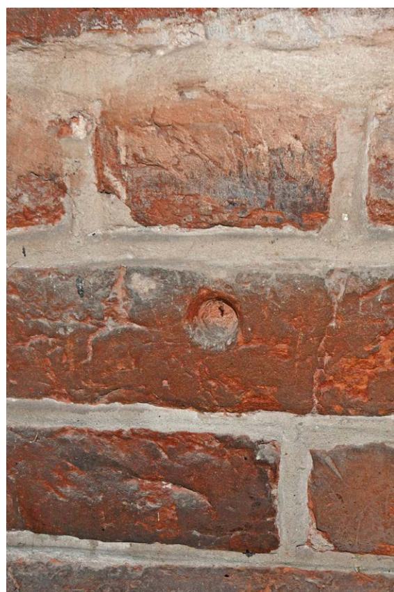
Il. 65. Kościół św. Mikołaja, elewacja zachodnia – kruchta zachodnia (2023): 1 – sklepienie, 2 – ściana północna, 3, 4 – ślady po świdrach ogniowych; fot. F.H.
