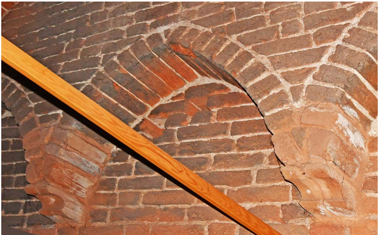
Il. 84. Kościół św. Mikołaja – wnętrze wieży (2023): 1 – przekrój, 2, 3 – ślepe arkady na ścianie południowej empyry; fot. i oprac. F.H.
