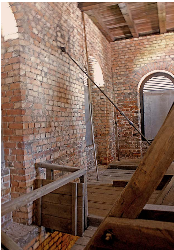
Il. 86. Kościół św. Mikołaja (2014) – wnętrze wieży: 1 – czwarta kondygnacja, 2, 3 – piąta kondygnacja z konstrukcją nośną dzwonów; fot. E.Ł.
