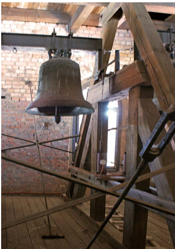
Il. 86. Kościół św. Mikołaja (2014) – wnętrze wieży: 1 – czwarta kondygnacja, 2, 3 – piąta kondygnacja z konstrukcją nośną dzwonów; fot. E.Ł.
