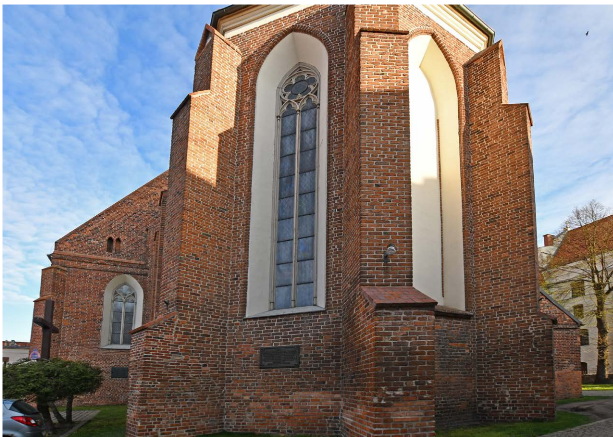
Il. 49. Kościół św. Mikołaja, elewacja wschodnia (2023); fot. F.H.
