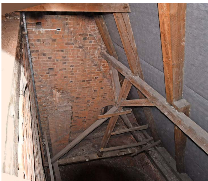
Il. 98. Kościół św. Mikołaja – strych nad nawą główną, szczyt zachodni (2023): 1 – ściana szczytowa prezbiterium od strony korpusu, 2 – górna część szczytu nawy głównej, 3 – półszczyt nawy północnej; fot. F.H.
