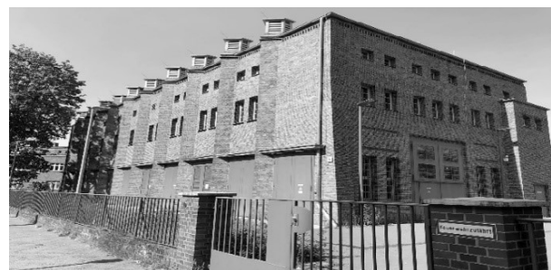
Figure 1: Gleichrichtwerk Tegel in spring 2023.
