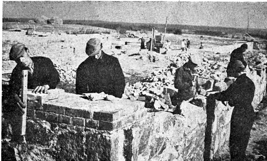
Członkowie brygady remontowo-budowlanej z PGR Grudynia Wielka przy pracy. Cokół chlewni na 70 macior gotowy
